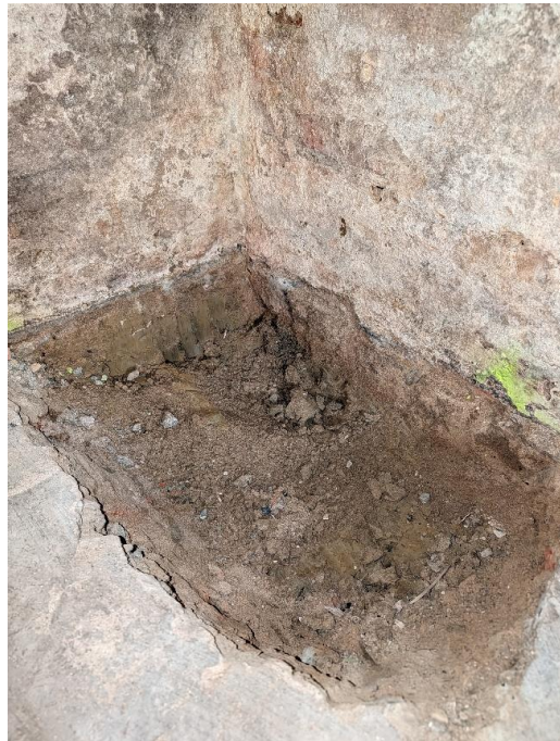
Kellergeschoss – Schürfgrube an Mittellängswand zu nicht unterkellertem Bereich (links) und Giebelwand (rechts)
