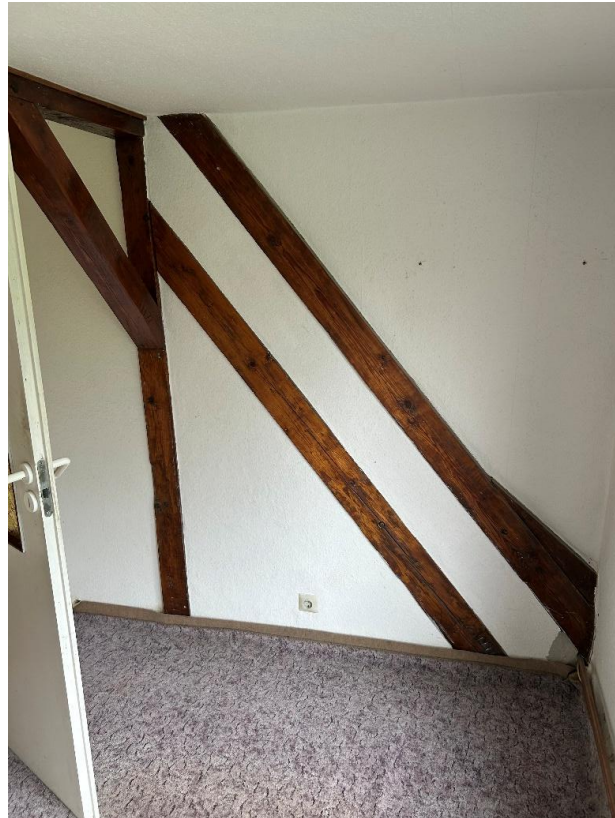
Dachgeschoss – Zwerchhaus im Westen
