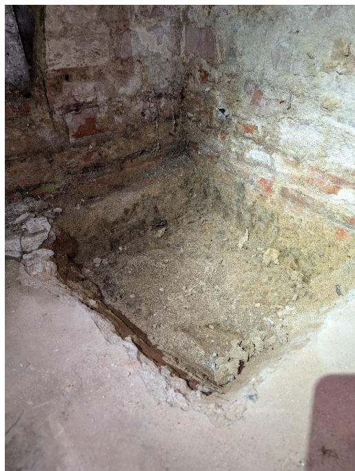
Kellergeschoss – Schürfgrube an Traufwand (links) und Querwand zu nicht unterkellertem Bereich (links)
