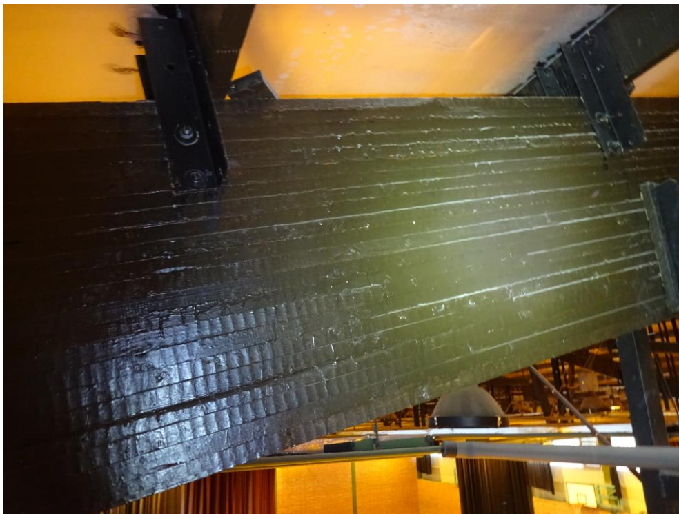
Klebebinder Achse 16/G-I: 3 Risse, Risstiefen punktuell bis zu ca. 12mm, ca. 22mm und ca. 22 mm, bis ca. 1,2 m lang
