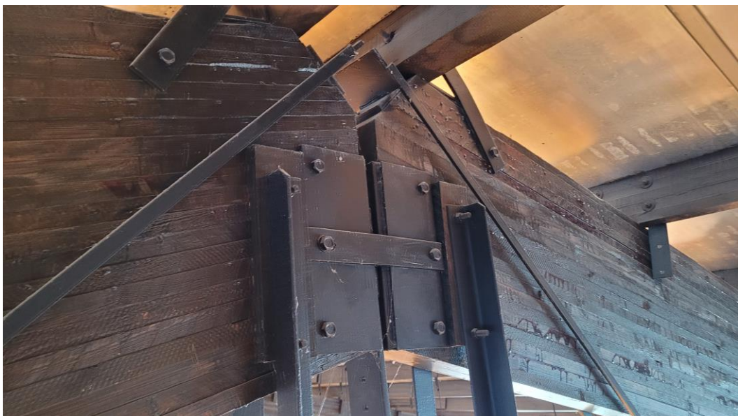
Firstbereich Klebebinder Achse 8/I
