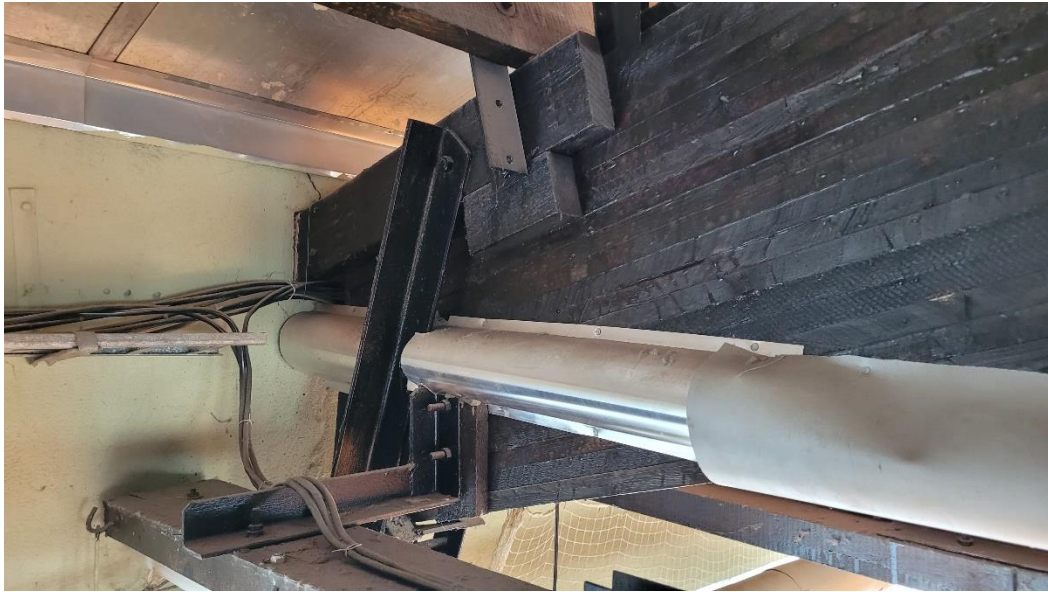
Auflagerbereich Klebebinder Achse 8/F
