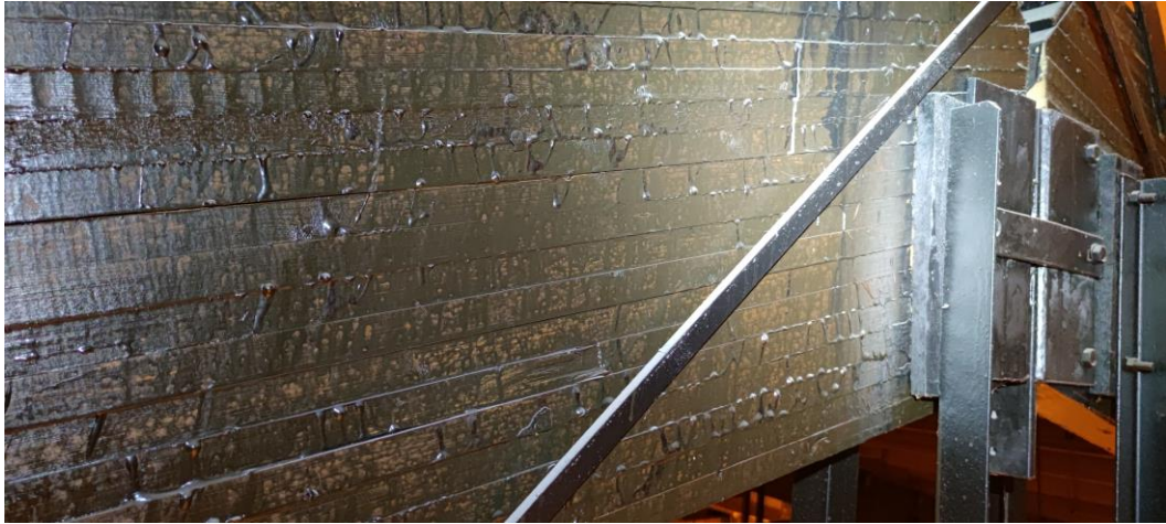
Firstbereich Klebebinder Achse 16/I: Risstiefe punktuell bis zu ca. 30 mm, ca. 1,5 m lang
