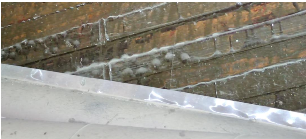
Klebebinder Achse 4/F-G: Verunreinigung, möglicherweise Insekten- oder Schimmelpilzbefall
