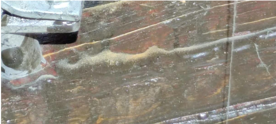
Klebebinder Achse 20/N-M: Verunreinigung, möglicherweise Insekten- oder Schimmelpilzbefall
