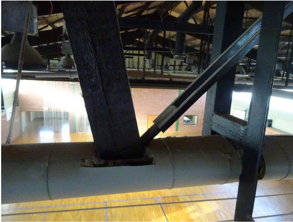
Klebebinder Knotenpunkt Zugband-Druckstrebe-Zugstrebe Achse 10
