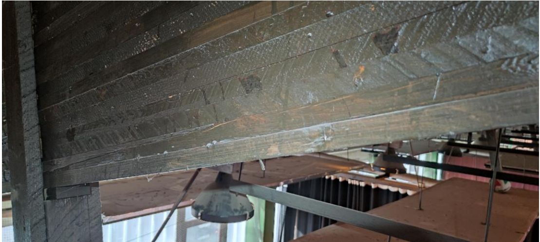
Klebebinder Achse 6/L: Riss bis zu ca. 15 mm tief, ca. 1,0 m lang
