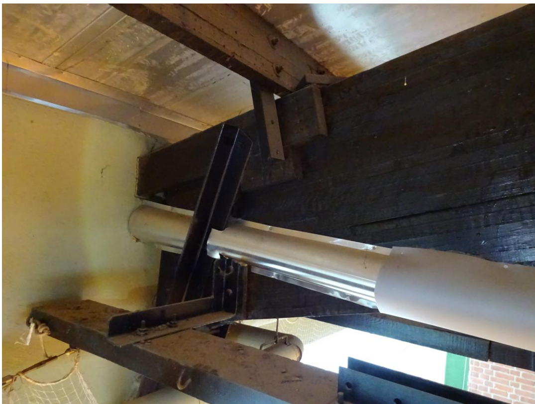
Auflagerbereich Klebebinder Achse 18/N
