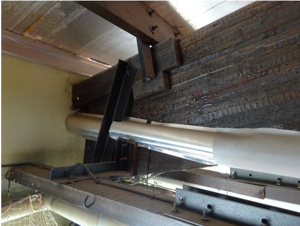
Auflagerbereich Klebebinder Achse 10/N
