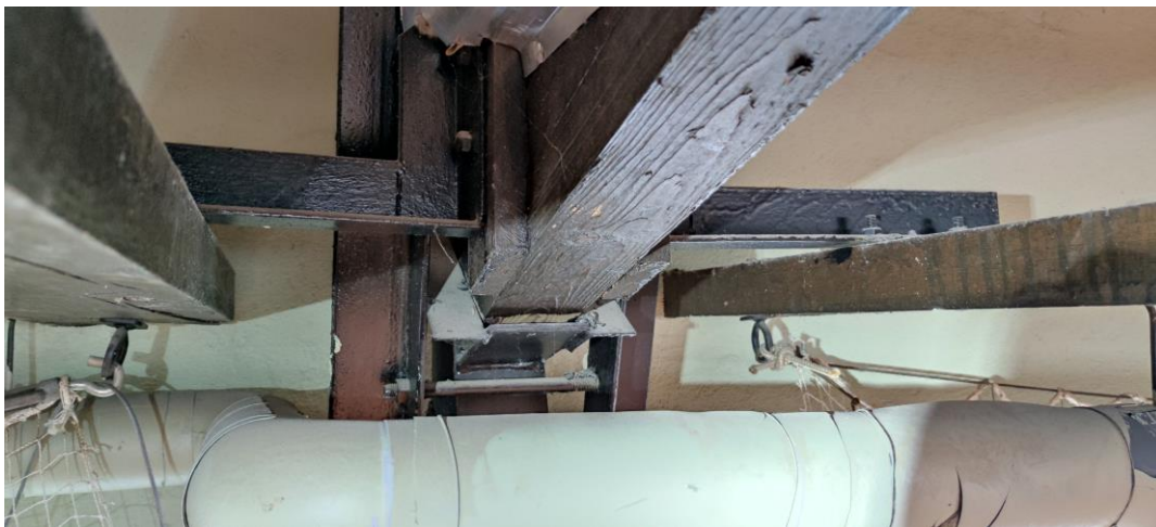
Auflagerbereich Klebebinder Achse 6/F: Abstand zwischen Unterkante Binder und darunter liegendem Blech ca. 15 mm – ähnliche Situation in allen Auflagerbereichen der Klebebinder
