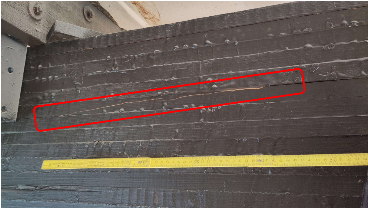
Abbildung 12 - Schwindriss am Binder 16 G/H Lamelle 6 – Achse 16 Ansicht Nord – Grottker
