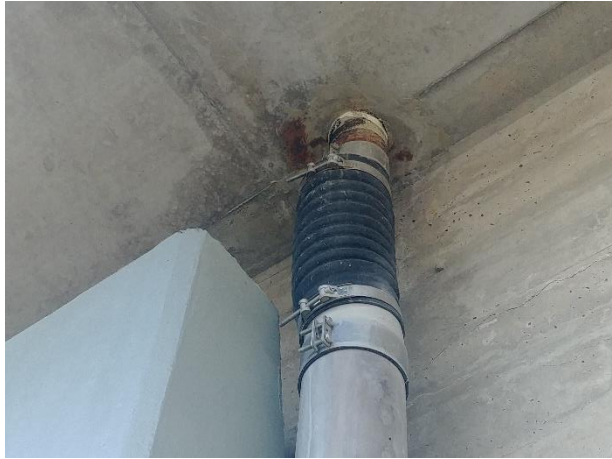
Abbildung 3: Rostiges Entwässerungsrohr durch den Überbau am Widerlager A10
