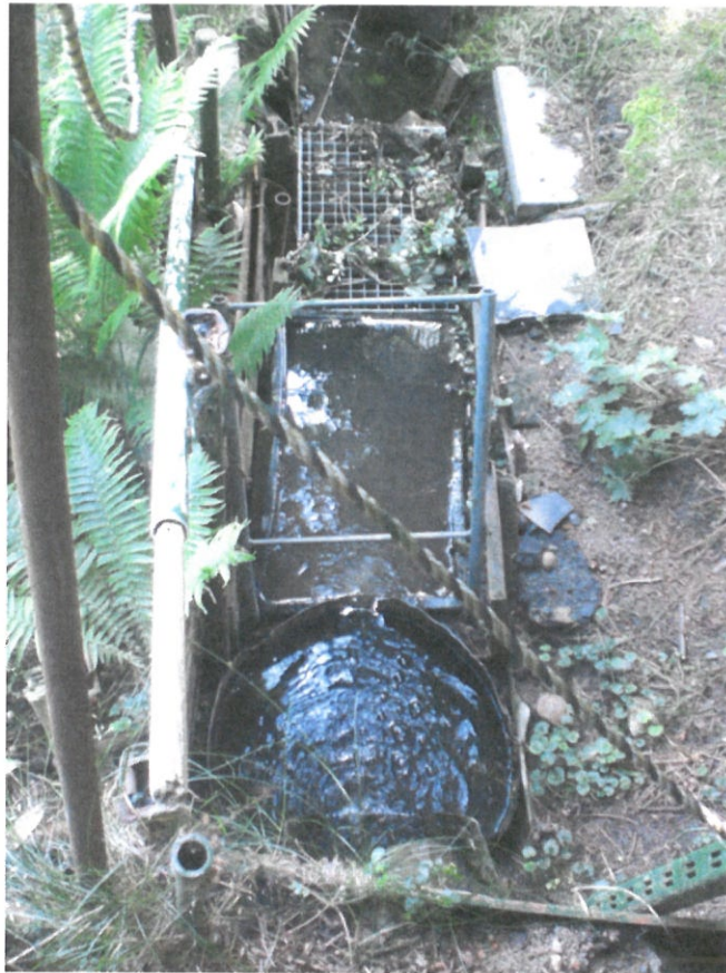
Bild 19: ... und in die Sohle Stahlwannen eingelassen.
