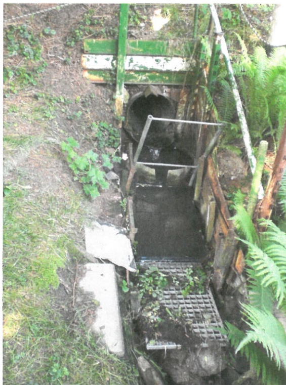
Bild 18: Zum Schutz gegen Auskolkung wurden die Uferbereiche abschnittsweise durch Anlieger behelfsmäßig befestigt ...
