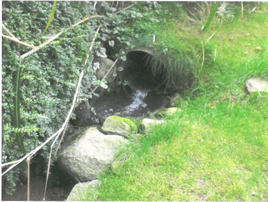
Bild 9: Zirka 40 m östlich des Schachtes von Bild 3 endet die Verrohrung (Stahlrohr DN350) und es beginnt das offene Gewässer KV23.
