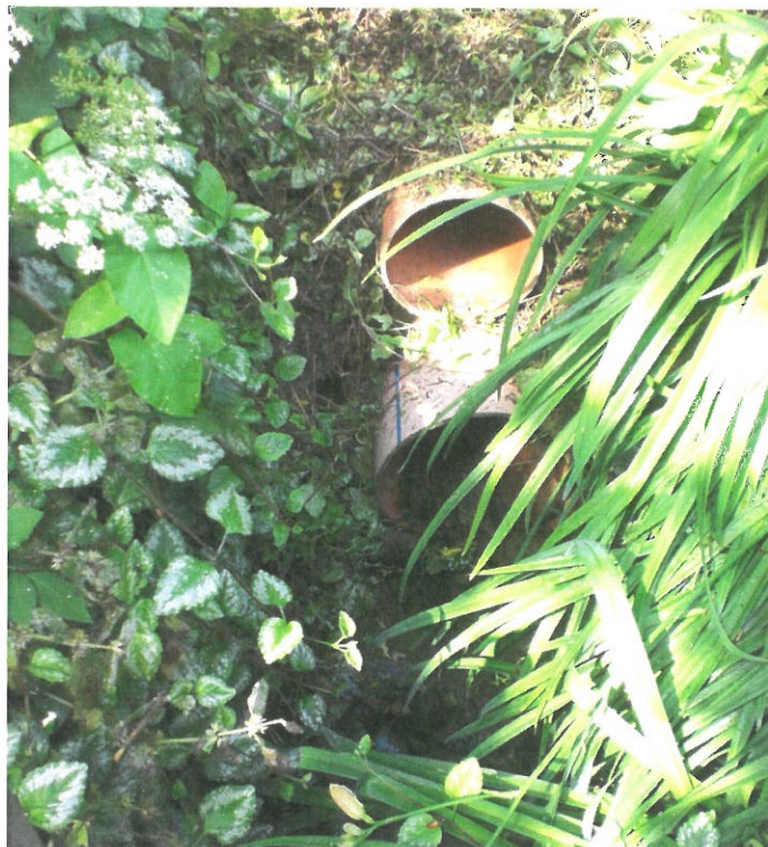
Bild 16: Unterhalb von Zuwegungen wurden zumeist mehrere kleinere Durchlassrohre verlegt, ...
