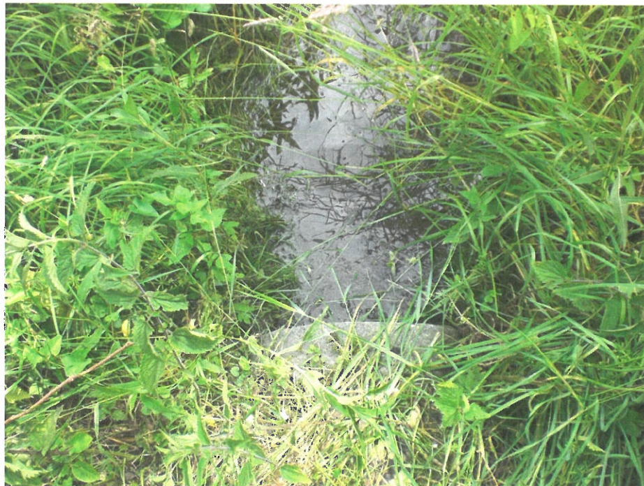
Bild 22: Das Gewässer KV23 quert den Weg mittels Betonrohr DN 400. Hinter der Quering ist das Gewässer naturnah ausgebildet.
