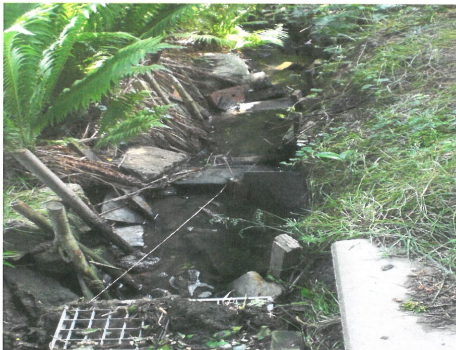
Bild 14: Bachsohle und Uferbereich wurden provisorisch mit Bauschutt (Beton und Stahlrohre) befestigt.
