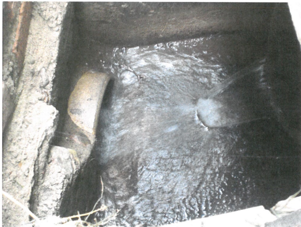
Bild 4: Innerhalb des Schachtes kommt es zu einer Reduzierung des Rohrquerschnitts (von DN 350 auf DN 250).
