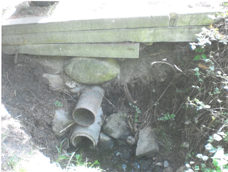
Bild 17: ... die bei Starkregen das Wasser des KV23 jedoch nicht aufnehmen können. In der Folge kommt es zum Aufstauen des Wassers und zum Überspülen der Zuwegungen.
