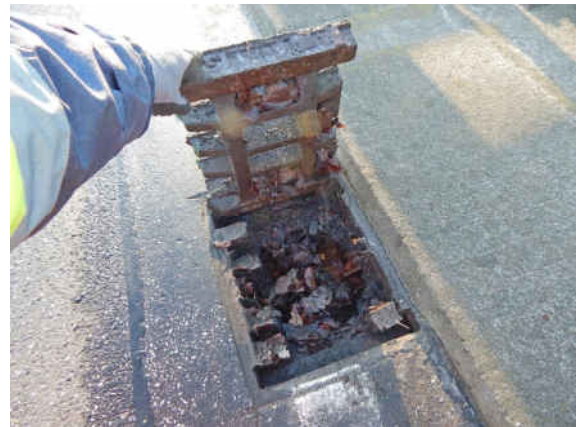
SN_041_0_2025E_ABLAUF VORNE VERSCHMUTZT
