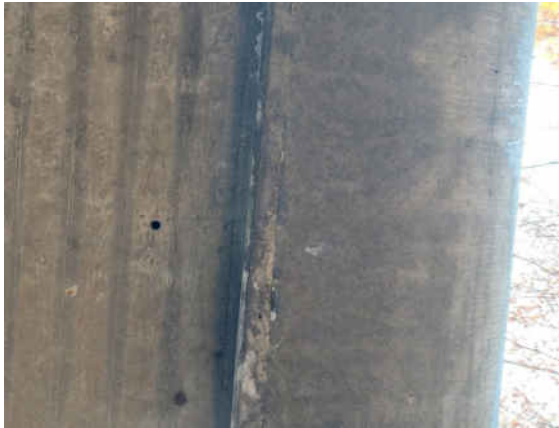
SN 041_2022H_L-KRAGARM F-1 VORNE VERSCHLUSS FEHLT
