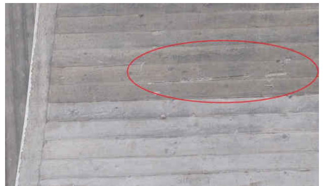
SN 041_2022H_RIEGEL RE KRATZSPUREN
