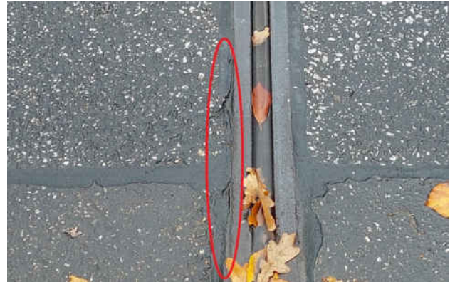
SN 041_2022H_BELAG VORNE VERGUSS ABGELÖST
