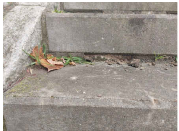
SN 041_2022H_H-R-TREPPE LAGERFUGEN BRÜCHIG
