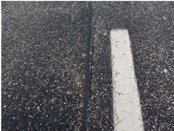
2334511_0_2017E_BELAG HINTEN MITTIG LÄNGSRISS
