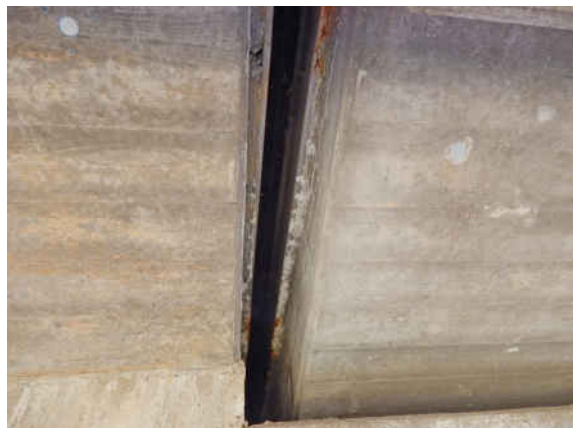
SN_041_0_2025E_FÜK WL-H LINKS UNTEN AUSSINTERUNGEN
