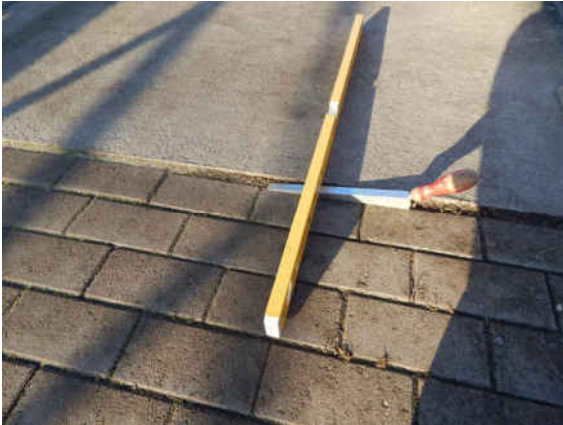
SN__041_0_2025E_R-WEG VORNE PFLASTER ABGESACKT
