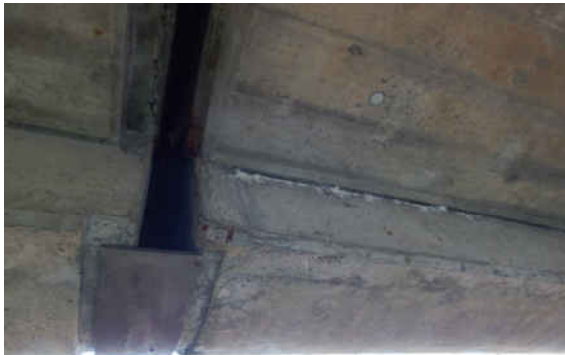
SN_041_0_2025E_L-KRAGARM F-1 VORNE AUßEN AUSSINTERUNGEN
