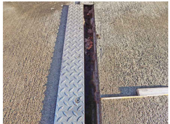
SN__041_0_2025E_FÜK WL-H RECHTS ABDECKBLECH LOSE
