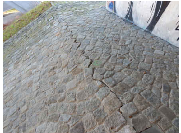
SN__041_0_2025E_BERMENPFLASTERUNG WL-V RECHTS OBEN QUERRISS
