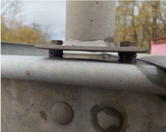
SN 041_2022H_R-EDSP AUFS-GEL HINTEN VERSCHRAUBUNG MANGELHAFT
