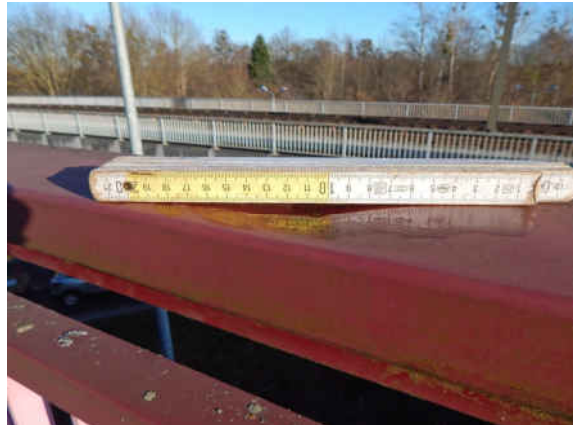
SN_041_0_2025E_R-GEL F-7 HANDLAUF EINGEDRÜCKT
