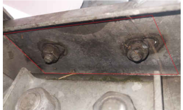
SN 041_2022H_R-EDSP UNTERLEGPLATTEN FEHLEN
