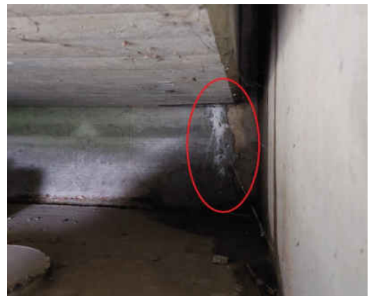
SN 041_2022H_K-WAND WL-VLINKS AUSSINTERUNG
