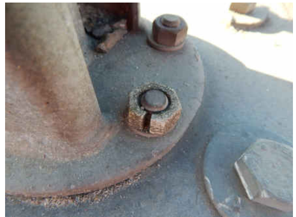
SN_041_0_2025E_R-EDSP HINTEN MUTTER GERISSEN
