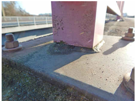
SN_041_0_2025E_R-GEL HINTEN PFOSTEN ENTW- ÖFFNUNG VERSTOPFT
