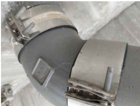
SN-041_2022H_MANSCHETTEN LWL UNZUREICHEND BEFESTIGT
