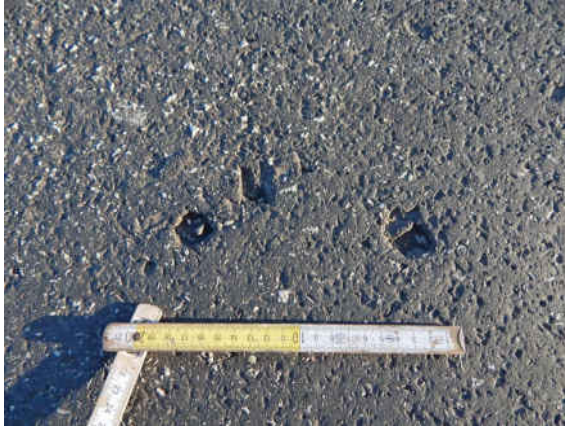
SN_041_0_2025E_BELAG VORNE RECHTS KORNAUSBRÜCHE
