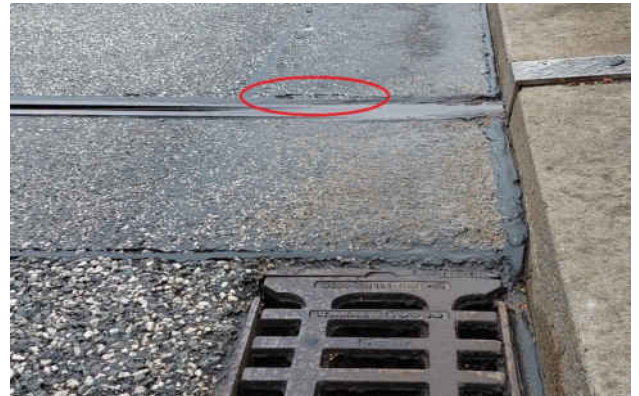
SN 041_2022H_BELAG HI LI FUGENFLANKE BRÜCHIG
