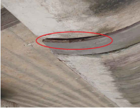
SN 041_2022H_ABDECKBLECH HI LI ROST
