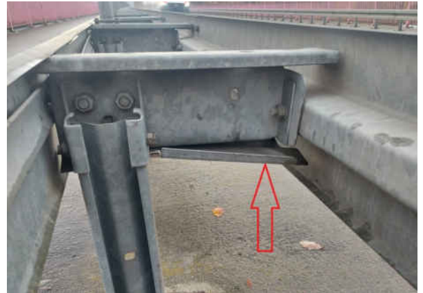
SN 041_2022H_R-EDSP H DISTANZSTÜCK VERBOGEN
