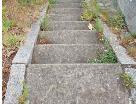
SN 041_2022H_H-R-TREPPE UNKRAUTBRÜCHIG
