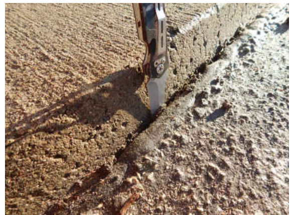
SN_041_0_2025E_BELAG R-FUGE MITTIG HERAUSGEQUOLLEN
