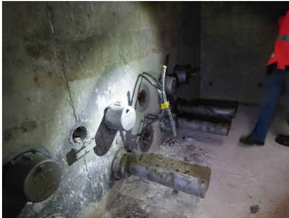
SN-041_2022H_H-KONTROLLSCHACHT MÖRTELRESTE
