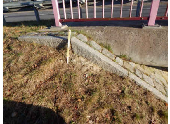
SN__041_0_2025E_L-BÖSCH WL-H OBEN ABGESACKT
