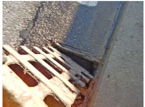
SN_041_0_2025E_ABLAUF HINTEN SCHARNIER GEBROCHEN
