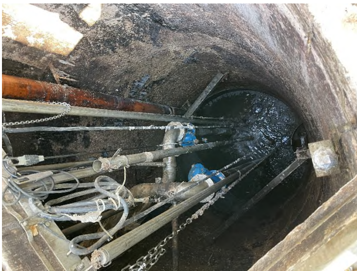
Abbildung 2-2: Pumpenschacht Hauptpumpwerk Hinte
