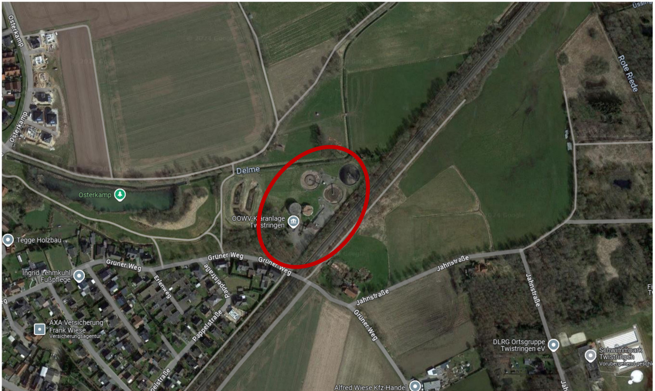
Abbildung 1: Luftbild des Planungsbereiches, Kläranlage Twistringen (Quelle: Google Maps)
