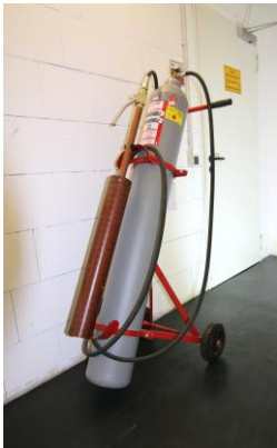
Bild: Fahrbarer Kohlendioxidfeuerlöscher, 30 kg
