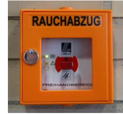
Bild: Manuelle Auslösung für eine Rauch- und Wärmeabzugsanlage
