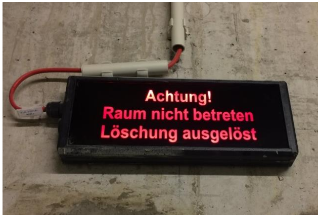
Bild: Warnleuchte für Gaslöschanlage
