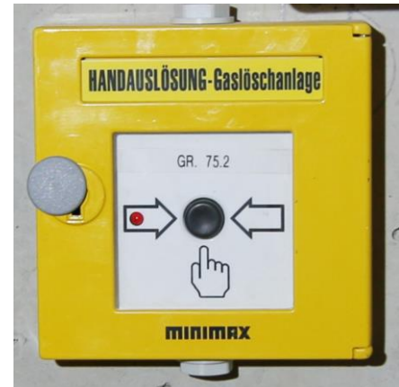
Bild: Manuelle Auslösung für Gaslöschanlage
