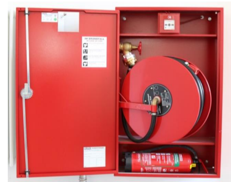
Bild: Wandhydrant mit Feuerlöscher und manuellem Brandmelder
