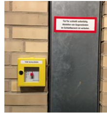
Bild: Manuelle Auslösung für ein Brandschutztor
