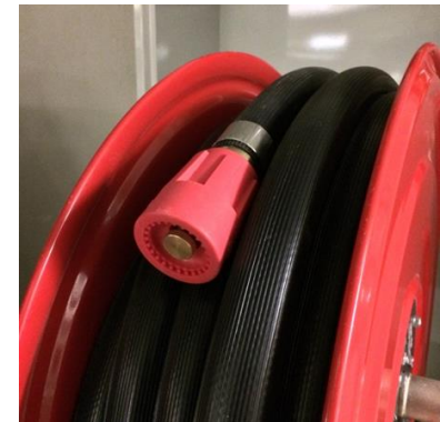
Bild: Wandhydrant mit formstabilem Schlauch und Euro-Düse
