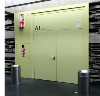
Bild: Hinweisbeschilderungen zu Brandschutzeinrichtungen im Audimax nach DIN ISO 7010
