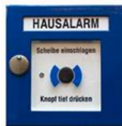
Bild: manueller Handfeuermelder Hausalarm
