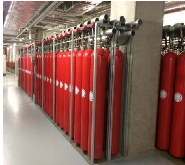
Bild: Argon-Löschzentrale ULB
