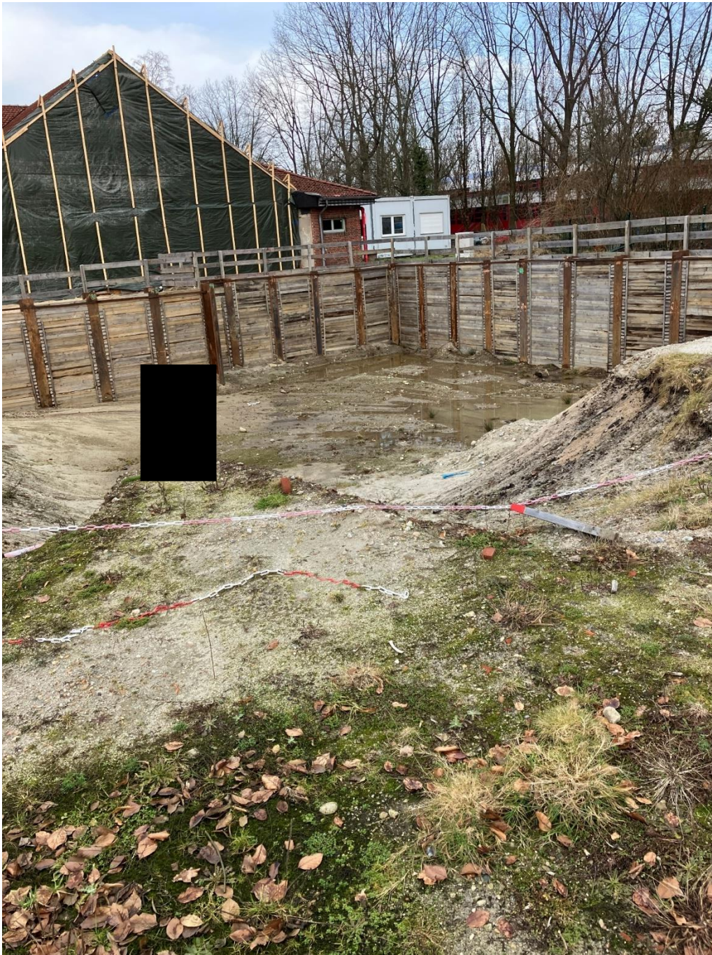
Foto 01.2 Baugrube und Trägerbohlenwand
