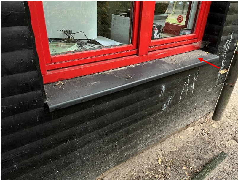
Abbildung 8: Die Fensterbänke im Außenbereich sind asbesthaltig.
