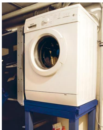
Entsiegelte Hochlagerung von Elektrogeräten Quelle: UBA (2011)
