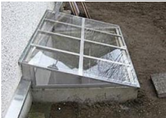
Schutz von Lichtschächten durch wasserdichte Abdeckung Quelle: DWA (2013)
