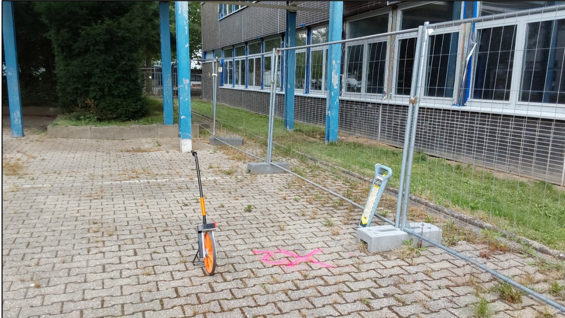
Abbildung 3: Baufläche Neubau Verbindungsgang mit Untersuchungspunkt Nr. 2
