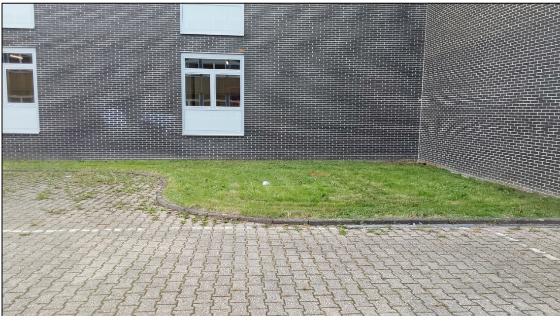
Abbildung 2: Baufläche Anbau Schule mit Untersuchungspunkt Nr. 1
