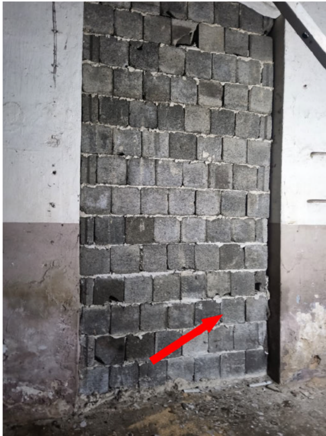
Abb. 3: Mit gekammerten Hohlblocksteinen vermauerte Öffnung mit Spaltenstrukturen (siehe Pfeil)
