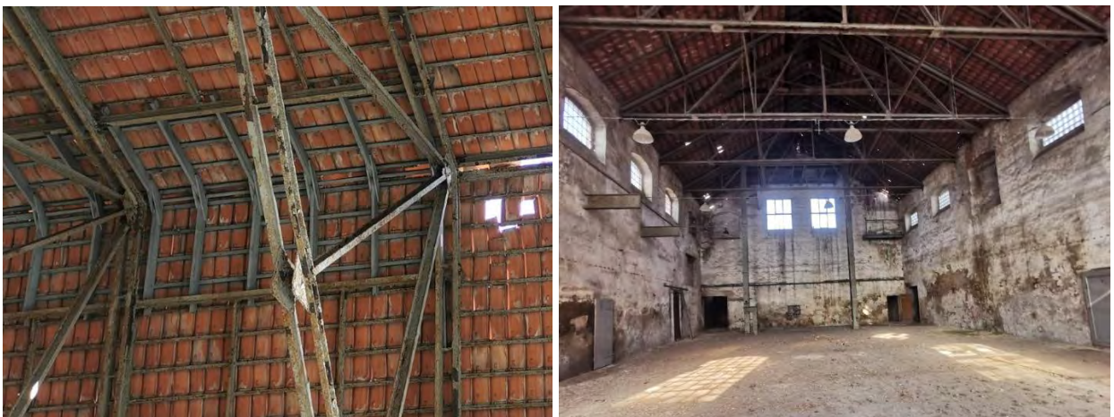
Abbildung 4 Aufbau des Giebeldaches (Raum 1)
