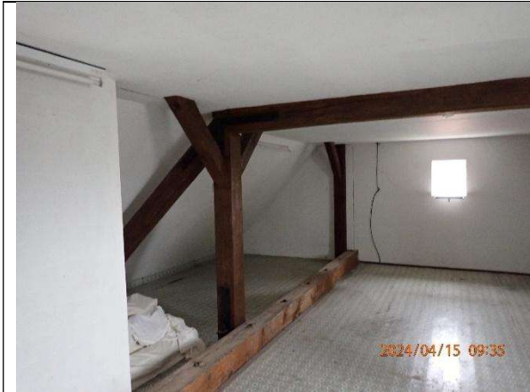
DG, West-/ Zentralbau, Dachgebälk
