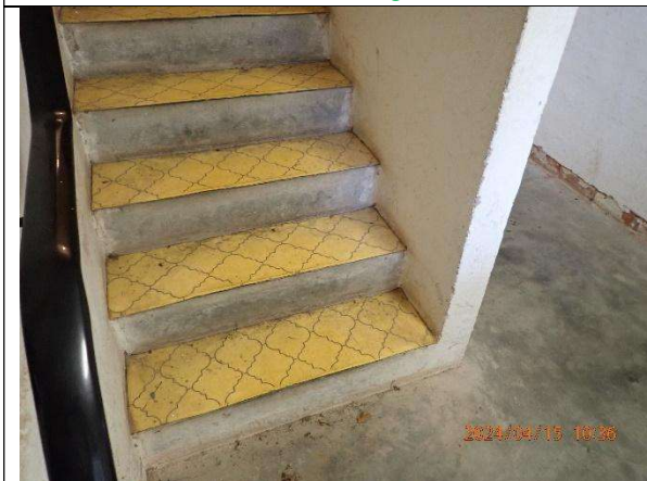
UG, TRH, Treppenstufe, Belagskleber MPA 2 24-15-00115-015 Kein Asbest nachgewiesen
