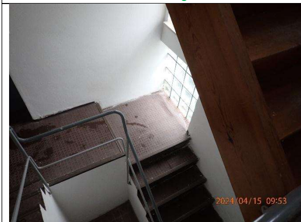
UG, TRH, Treppenstufe, Belagskleber MPA 2 24-15-00115-015 Kein Asbest nachgewiesen
