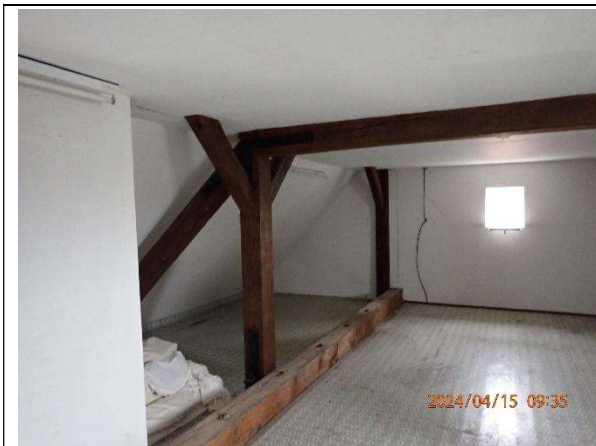
DG 1, West-/ Zentralbau, Spachtelmassen auf Leichtbauplatten
