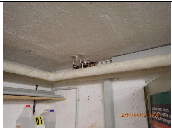
UG, Gang, Rohrummantelung, Gipsbinde MPEE 1 24-15-00115-014 Kein Asbest nachgewiesen
