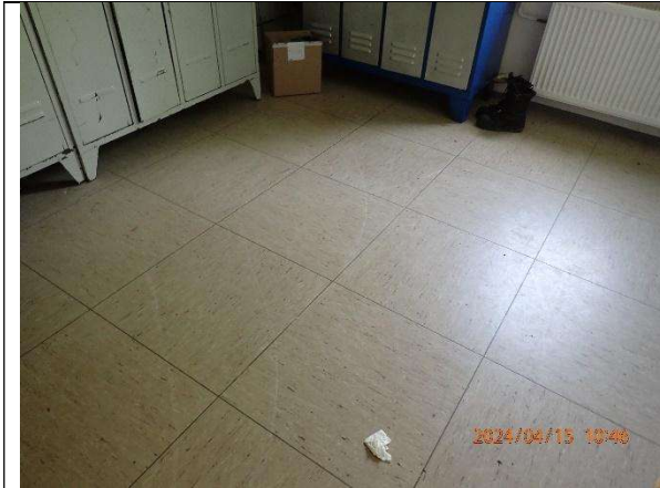
DG, Ostbau, Boden, Belag MPAEH 4 24-15-00112-011 Kein Asbest nachgewiesen
