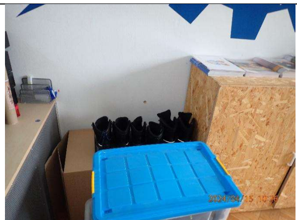
EG, Zentralbau, Wände, Spachtelmasse und Putz
