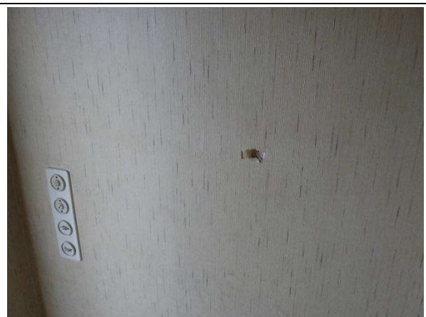
TRH, Spachtelmasse und Putz
