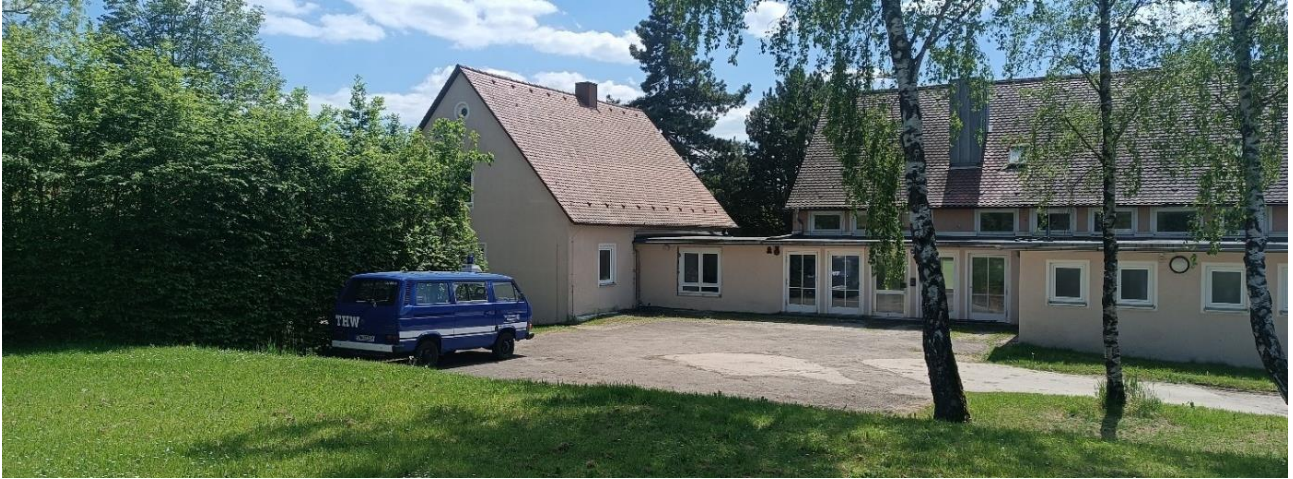
Abbildung 9: Bestandsgebäude mit versiegelter Hoffläche im Süden der Eingriffsfläche; (Foto: Bachmann Artenschutz GmbH)
