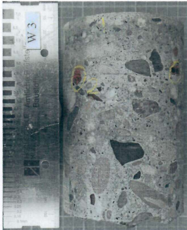
Bild 9: Bohrkern W3 Ansicht
