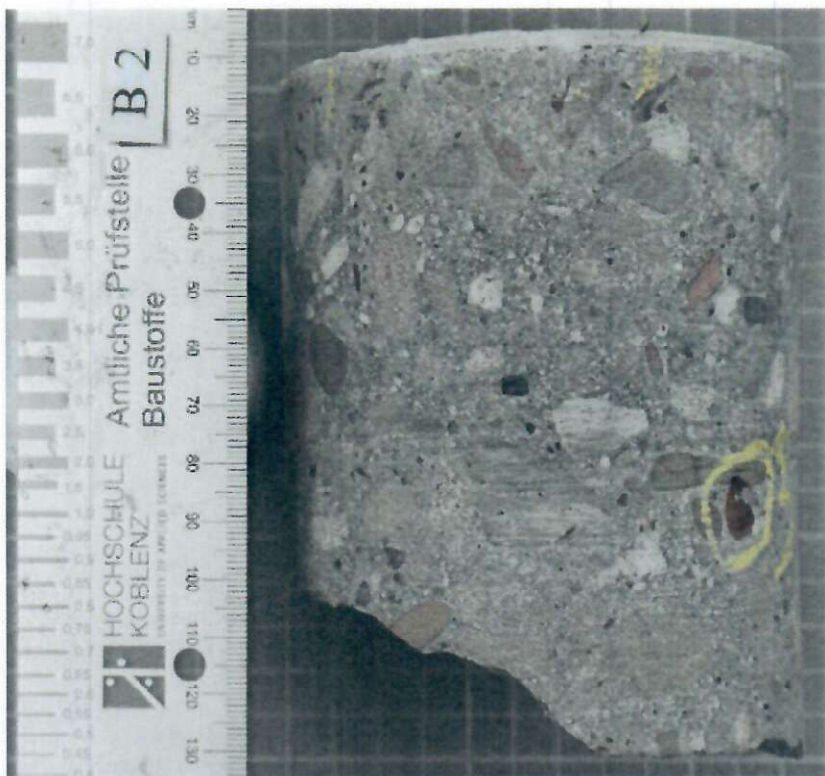
Bild 3: Bohrkern B2 Ansicht
