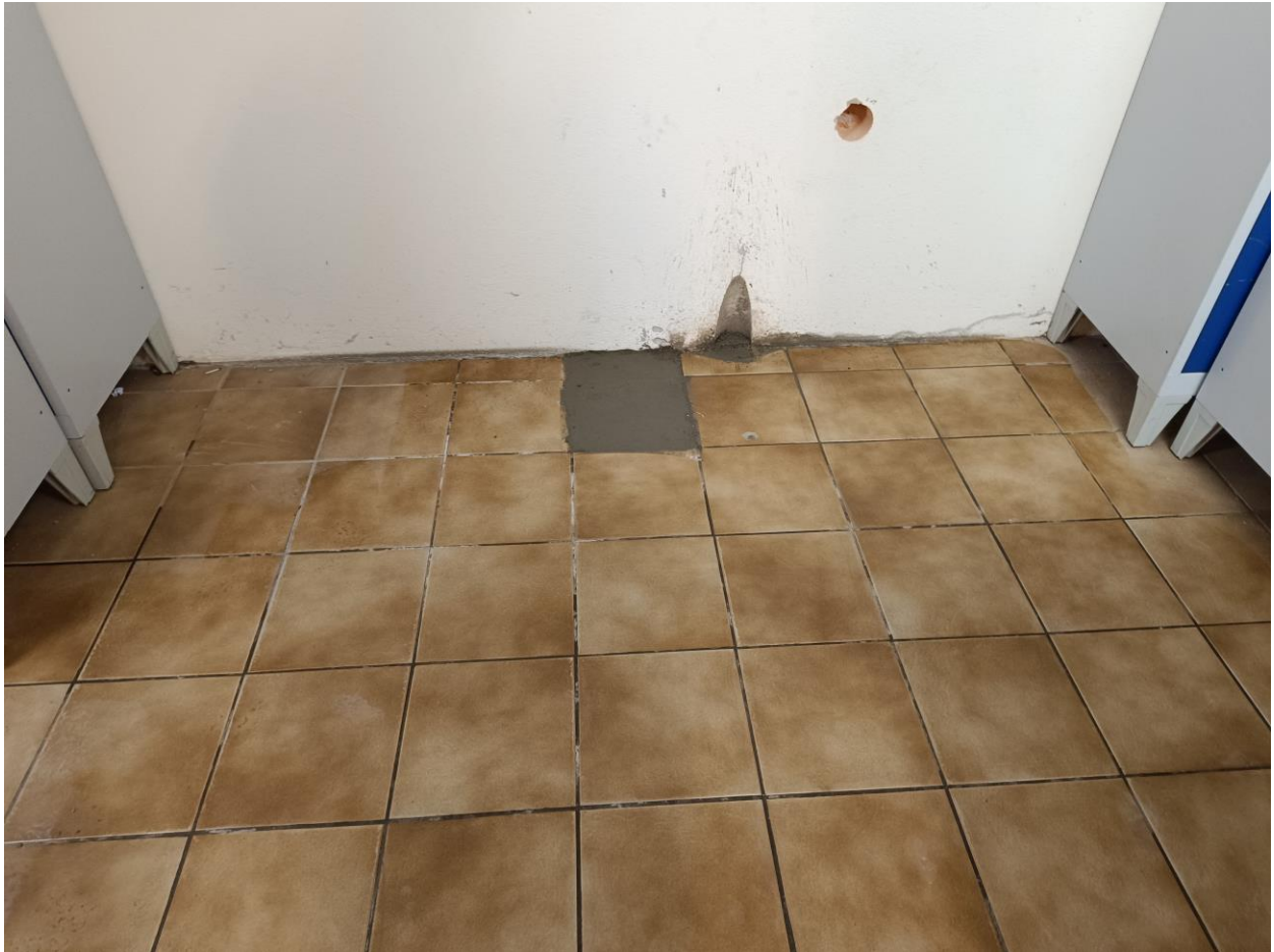
Bild 6: Ansatzpunkt nach Verschluss Schurf/ DKB
