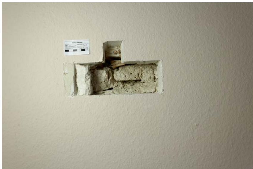
Obergeschoss, Raum 1.5, Westwand Befund 012 Aufbau mit Quellkalk/ Kalktuff wie in 010 und 011 nachgewiesen. Befundöffnung schneidet hölzernen Gefügeriegel und belegt Fachwerkkonstruktion, welche in 010 und 011 nicht nachgewiesen werden konnte.
