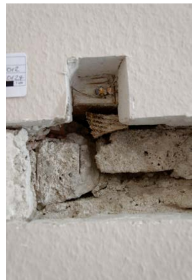
Obergeschoss, Raum 1.5, Westwand, Detail, auf Gefügeholz frühindustrielle Nägel und Drahtumwicklung als Putzarmierung. Am Gefüge Ziegel und Holzkeil zur Aussteifung. Auf Kalktuff liegen 3 cm starke Kalkputzrudimente, diese sind Reste eines feinen leicht bewegten Oberputzes mit Restschollen zweier monochromer Fassungen wie Keim-Palette Exclusiv 9456 und 9296 Darüber sehr feiner Kalk- oder Gipskalkputz auf Altoberputz wie in Abb. links beschrieben, 3 mm stark, direkt auf Kalktuff 4 cm stark mit glatt gefilzter Oberfläche, darauf Rauhfaserapete mit hellrosa Fassung wie Keim-Palette Exclusiv 9195
