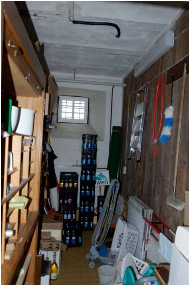
Erdgeschoss, Raum 0.6 Untergeordneter Raum mit nahezu unveränderter Raumaufteilung von 1837 (ohne Befundnummer) Fensterische im Westen zeigt Wandstärke der mittelalterlichen Wandaufbauten
