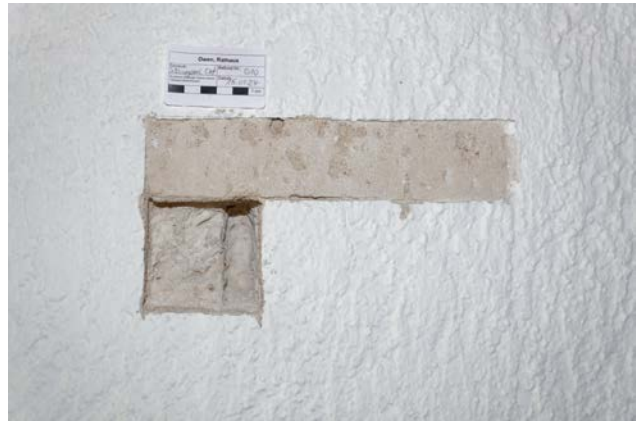
Obergeschoss, Raum 1.8, Befund 010, Wandaufbau insgesamt ca. 20 cm stark, Aufmauerung aus geschnittenen Quellkalkblöcken, mit feinem Kalkmörtel in Fugen und ca. 3 cm stark mit glatt gescheibter Oberfläche, beige rötlich mit wenigen Zuschlägen bis 1 mm, darüber ca. 0-2 mm starker Reibputz, wohl kunstharzvergütet mit Vertikalduktus und Einzelnen Reibekörnern bis 2 mm, altweiß gefasst wie Keim-Palette Exclusiv 9477 heller
