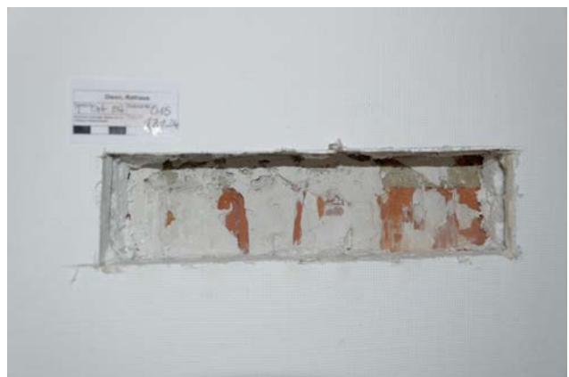
Erdgeschoss, Raum 0.3, Befund 015 industrielles Ziegelmauerwerk im Zementsetzmörtel, darauf kunsthartzhaltiger Klebeputz für 3 cm starke Styropordämmplatte, darüber 1,5 cm starke Gipskartonplatte mit feingliederiger Netzstrukturtapete mit altweißer Fassung wie Keim-Palette Exclusiv 9477 heller
