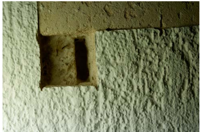
Befund 010 Streiflicht mit Oberflächenduktus der letzten Sanierung
