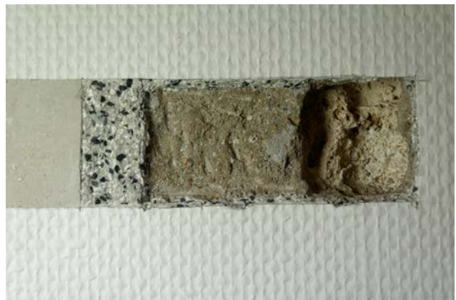
Obergeschoss, Raum 1.1, Befund 011, Aufbau aus Quellschutt mit egalisierendem hellem Kalkputz mit Zuschlag von grauen und schwarzen Rundkieseln bis 5 mm, darüber ca. 2 cm feiner Kalkputz mit feinen Zuschlägen mit leicht rauher Oberfläche, Oberputzlage aus feiner hellgrauer Matrix mit größeren scharfkantigen Zuschlägen 2 bis 5 mm in weiß und schwarz, Putz sehr hart, wohl Industrieprodukt. Abschließend sehr glatte hauchdünne warmgraue Oberfläche mit Glasfasertapete altweiß gefasst, wie in 015 und 010.
