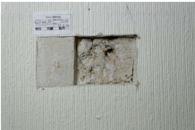
Obergeschoss, Raum 1.9, Befund 014, Südwand Wandstärke vergleichbar Befund 010 bis 013, Grundaufbau Kalktuffblöcke, darauf ca. 2,2 cm starker, Kalk- oder Gipskalkputz wie bereits für Befund 013 beschrieben, darauf eine vertikal strukturierte Tapete mit altweiß, gelblichem Anstrich wie Keim-Palette Exklusiv 9058
