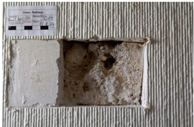
Obergeschoss, Raum 1.9 Befund 014 Südwand Streiflichtaufnahme: regionaler Quellkalkblock als Grundaufbau
