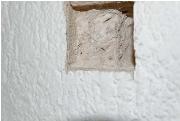
Befund 010 mit Aufbau aus gesunden Quellkalkblöcken 2 (auch Kalktuff genannt)
