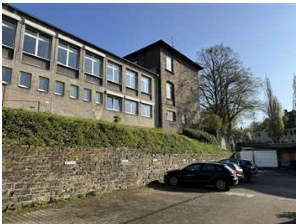
Erweiterungsbau mit Altbau, Südseite
