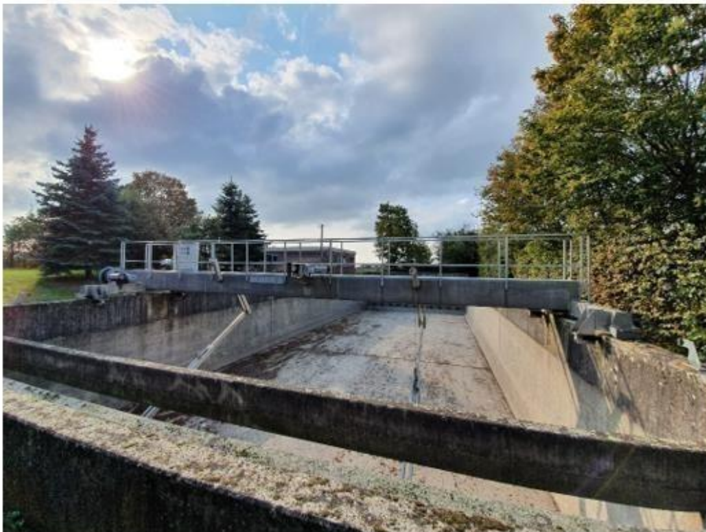
Bild 12, 13: Regenüberlaufbecken mit Räumer
