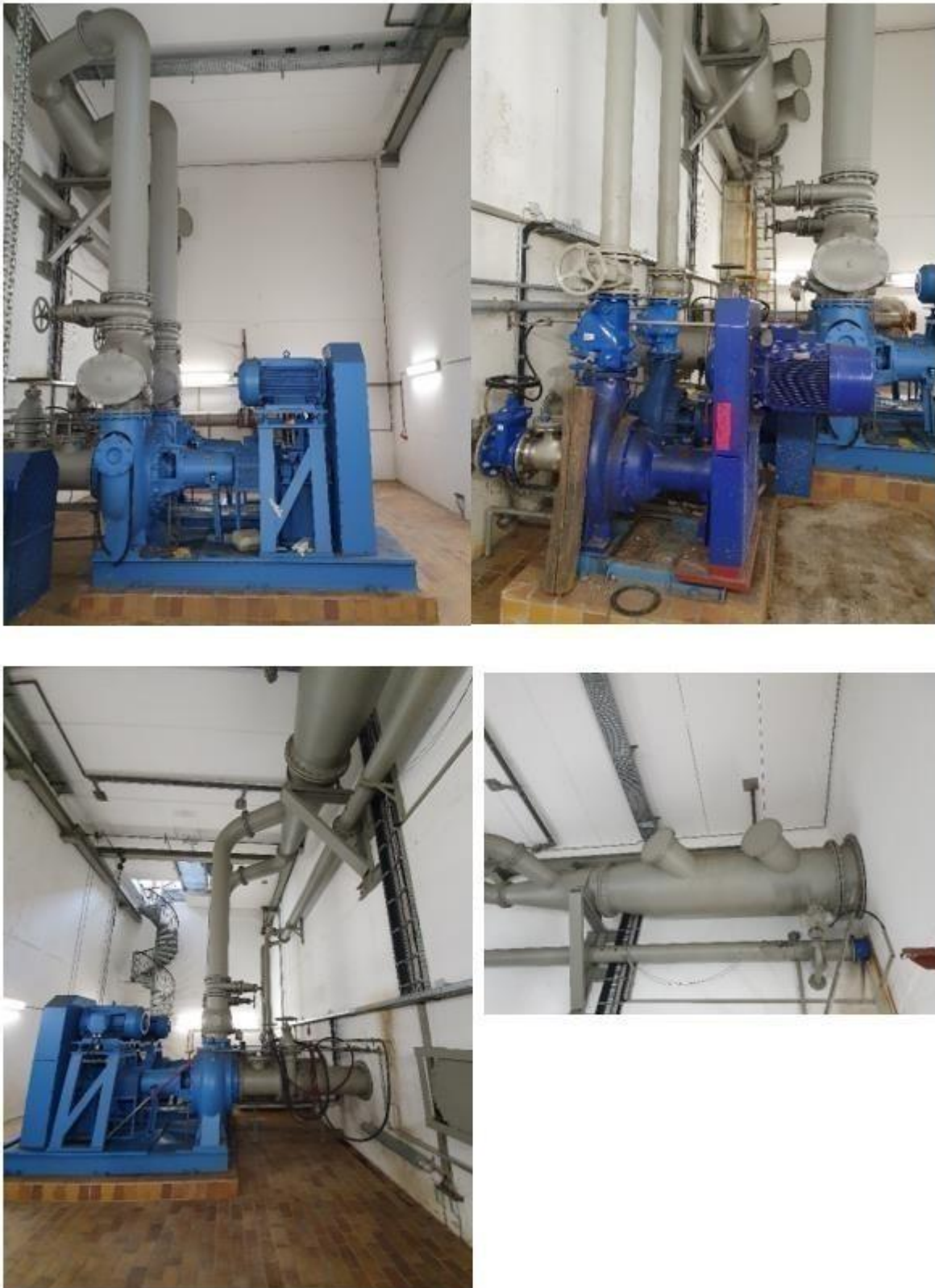
Bild 8-11: UG Trocken- u. Regenwetterpumpen inkl. Druckleitungen
