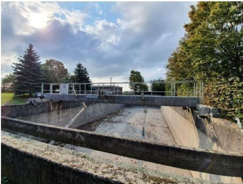
Bild 12, 13: Regenüberlaufbecken mit Räumer
