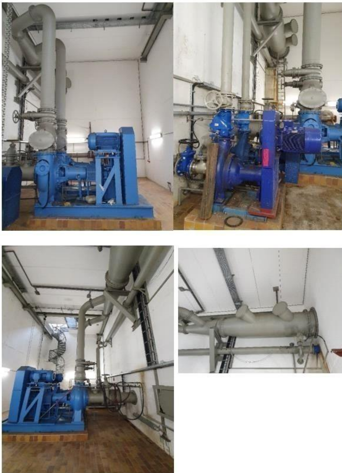
Bild 8-11: UG Trocken- u. Regenwetterpumpen inkl. Druckleitungen
