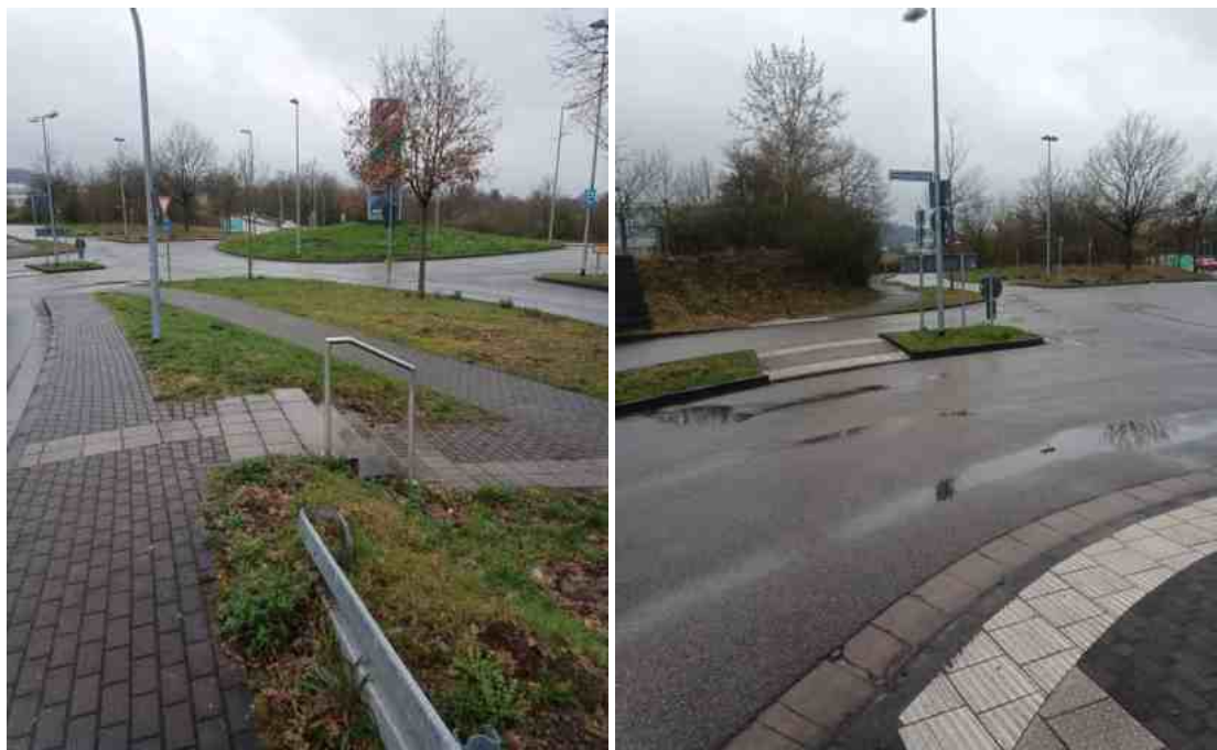
Abbildung 16: Treppenverbindung als Abkürzung zwischen zwei Gehwegen am Kreisverkehr K4
