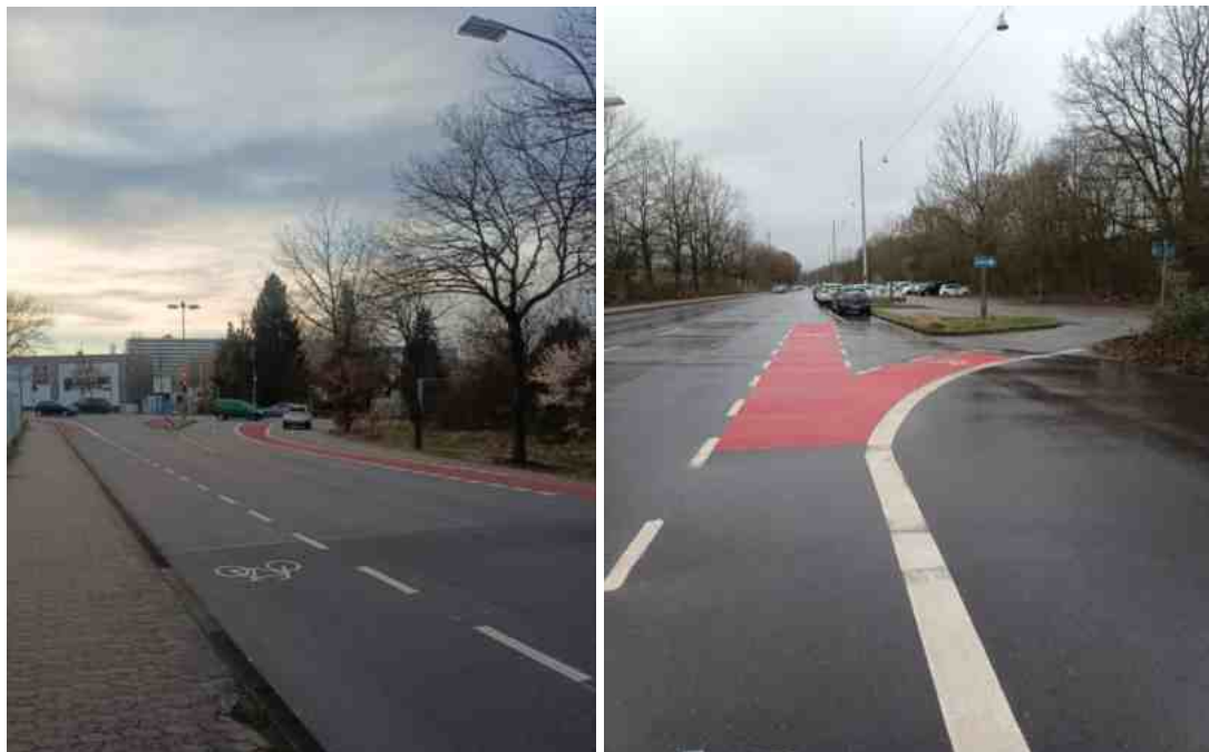
Abbildung 21: Radverkehrsführung in Kreuzungsbereichen – Knotenpunkt K2 Metzger Straße / Südring (links) und aufgeteilte Radführung Zufahrt in den ZF-Parkplatz am Südring (rechts)
