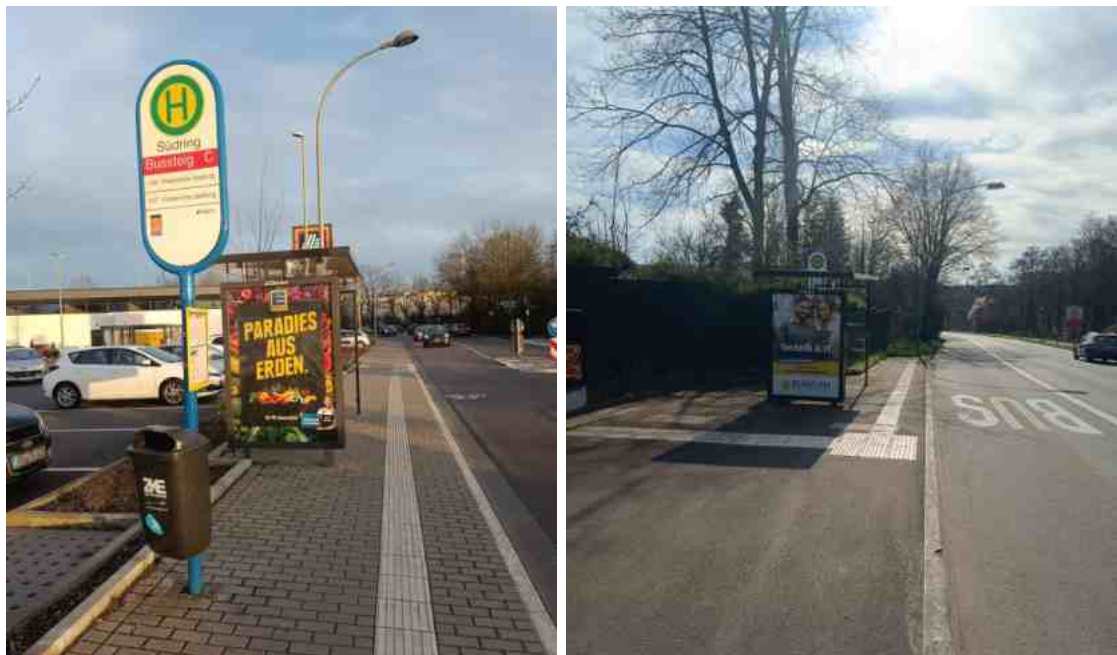
Abbildung 28: Bushaltestellen mit Wartehäuschen und taktile Orientierungshilfen für sehbehinderte Personen
