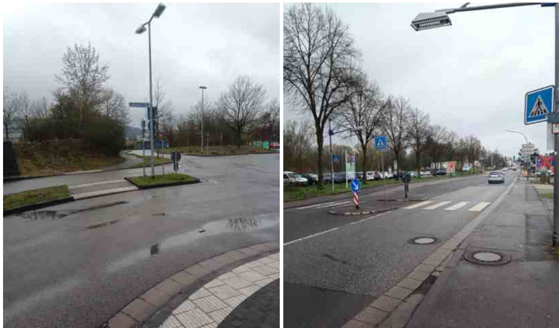
Abbildung 13: Querungshilfe Kreisverkehr K4 (links) und Zebrastreifen (rechts) beide über die Metzger Straße
