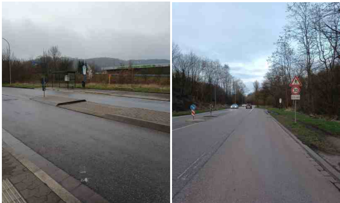
Abbildung 15: Querungshilfen für Erreichbarkeit von Bushaltestellen – Untertürkheimer Straße (links) und Deutschmühlental (rechts)
