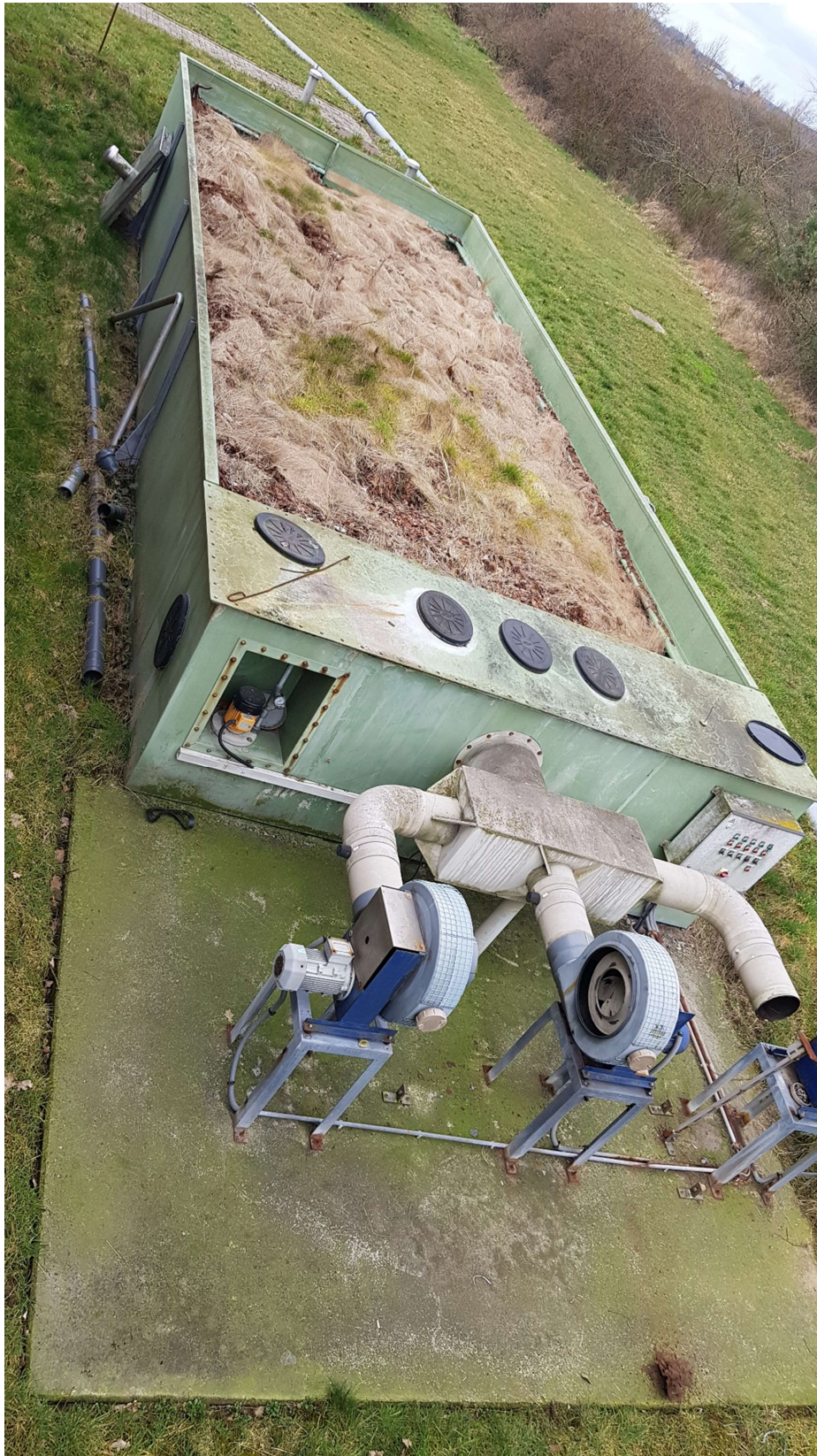
Abbildung 13: Biofilter Bestand
