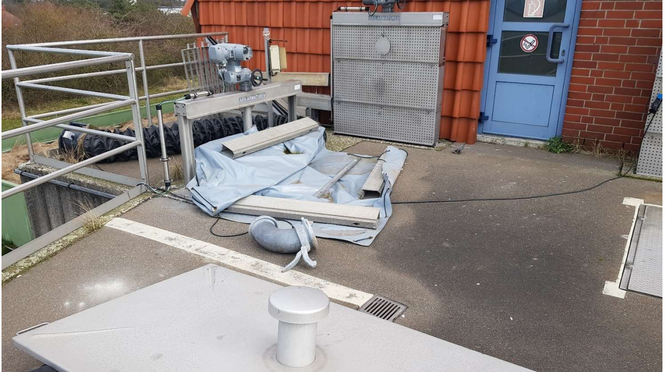
Abbildung 39: Vorhandene Abdeckungen Zulaufbauwerk Rechen
