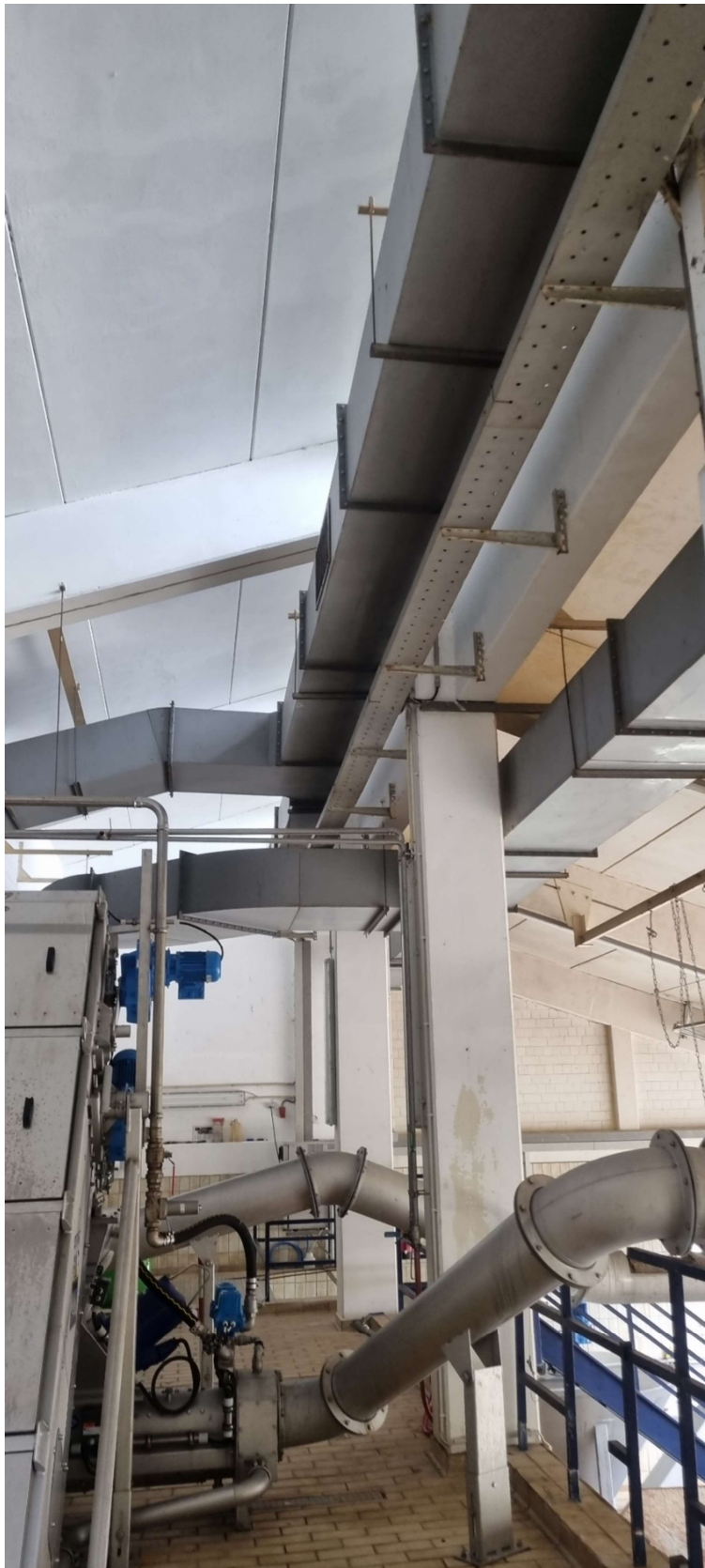
Abbildung 10: Rechenhalle, Abluftkanal 1 im Deckenbereich oberhalb der Zuluft
