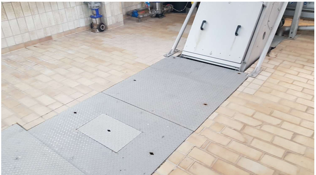
Abbildung 41: Abgedeckte Rechengerinne
