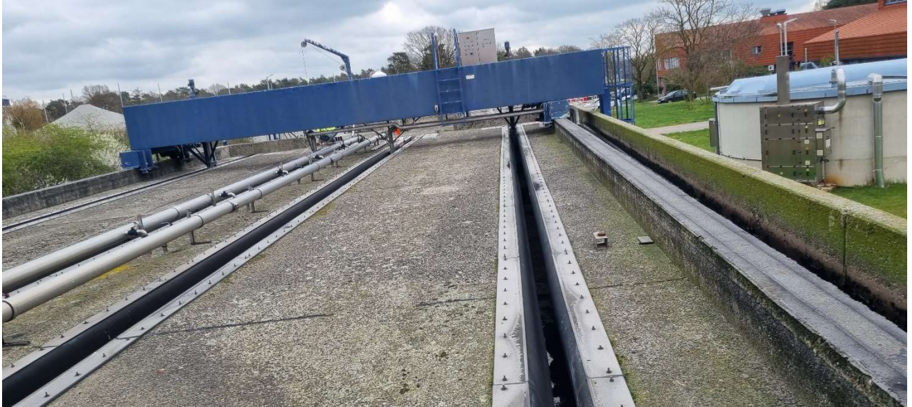
Abbildung 50: Sandfangschlitze der Sandräumer
