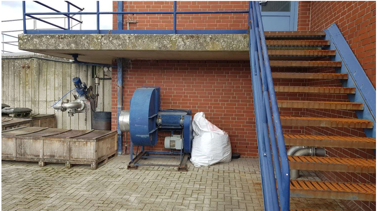
Abbildung 38: Treppenanlage Zulaufbauwerk Rechen
