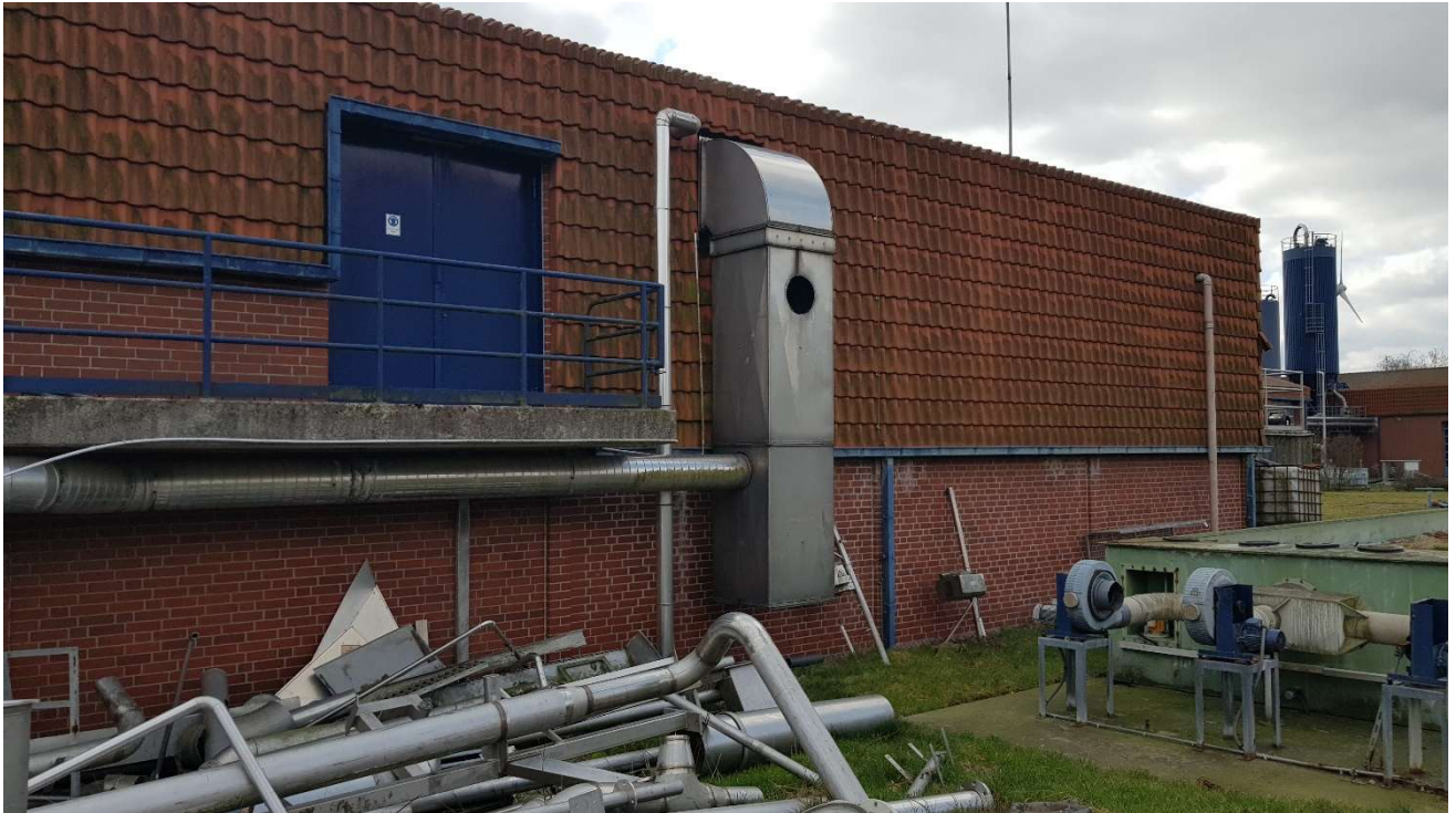
Abbildung 14: Biofilter Bestand, Sammelkanal Rechengebäude und Sandfang
