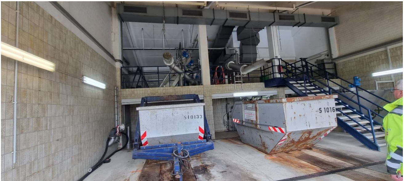
Abbildung 8: Rechenhalle, Frischluft/Warmluftkanal mit Blick auf die Rechengutcontainer
