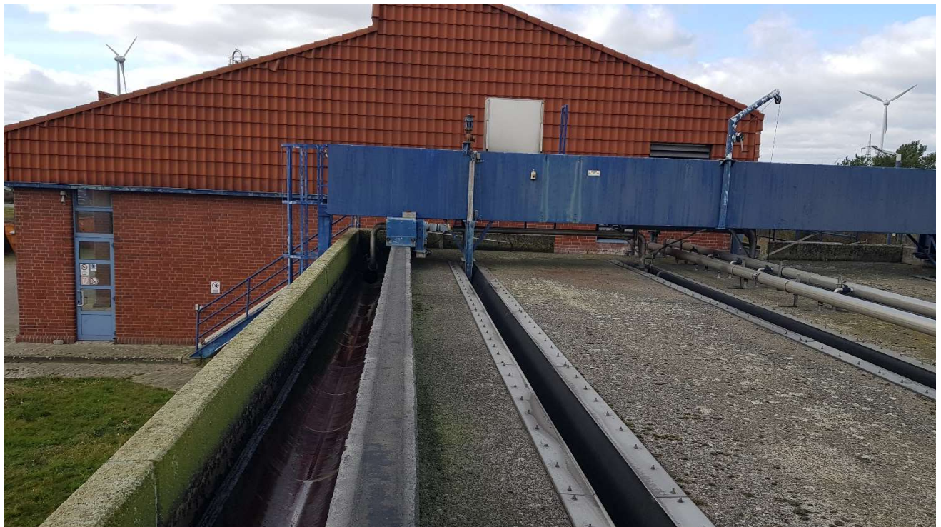
Abbildung 16: Sandfang, im Hintergrund das Rechengebäude
