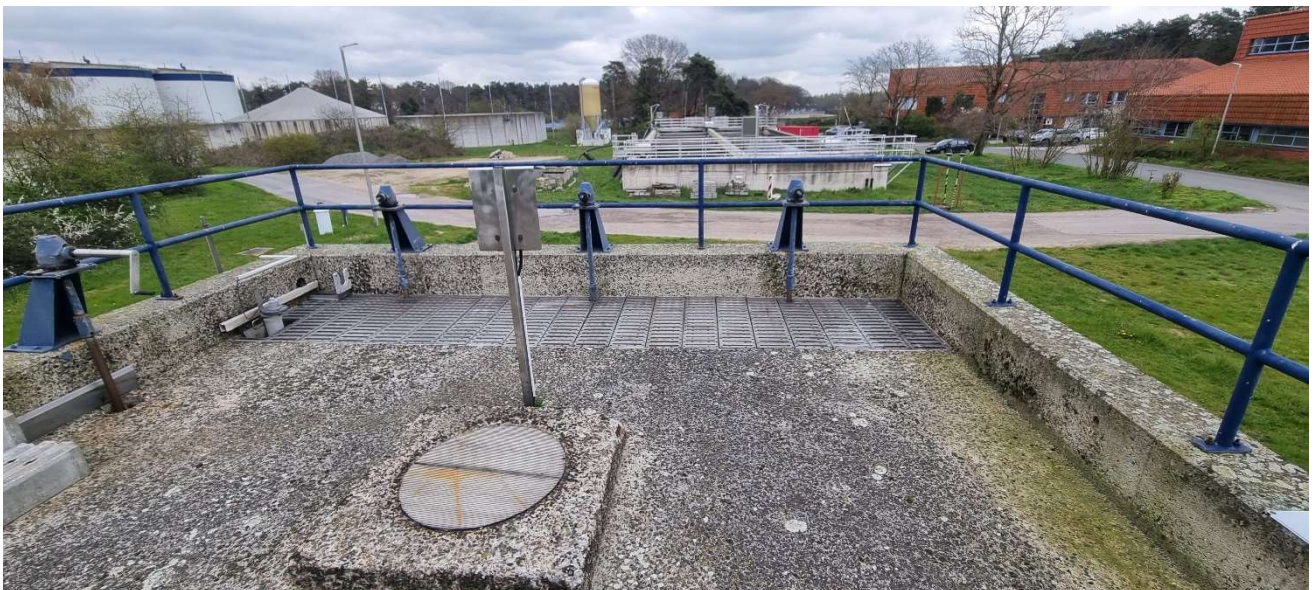
Abbildung 51: Ablaufbauwerk Sandfang
