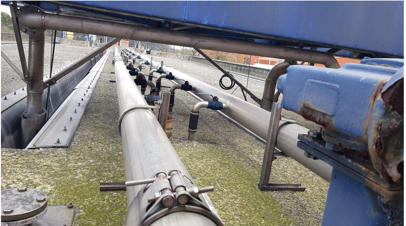
Abbildung 17: Sandfangbelüftung
