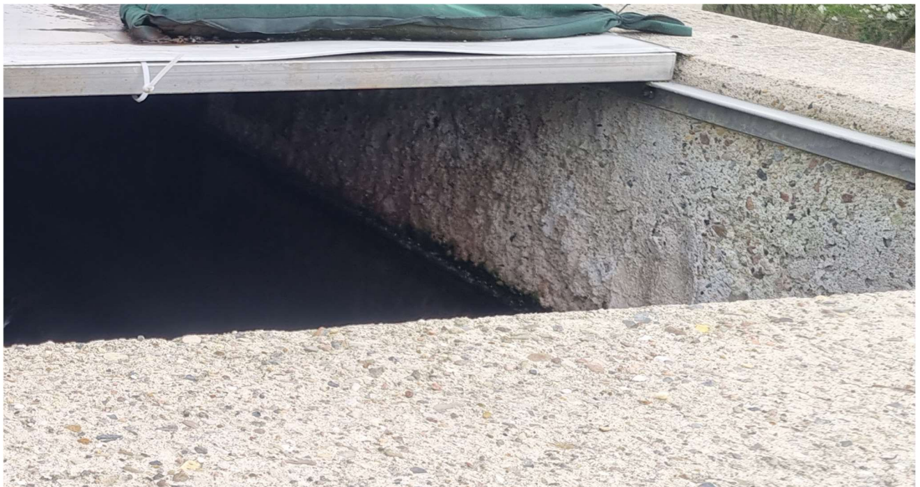
Abbildung 21: Ausschnitt Ablaufschacht Vorklärbecken, April 2023
