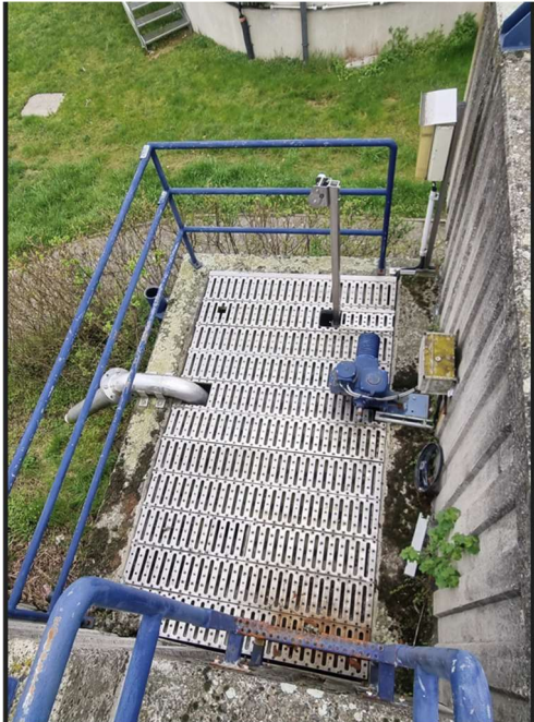
Abbildung 52: Fettfangsammlerschacht
