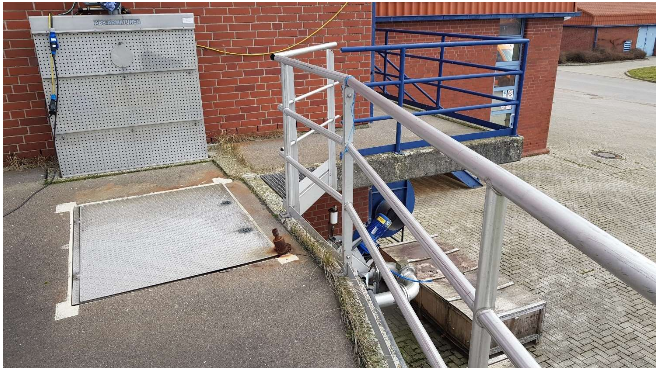
Abbildung 40: Vorhandene Abdeckungen Zulaufbauwerk in Richtung Rechen 2
