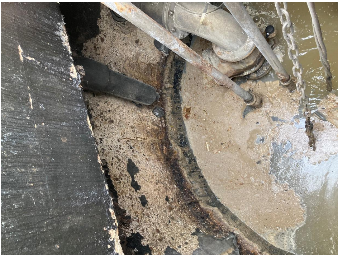
Führungsrohre und Rohrleitung
