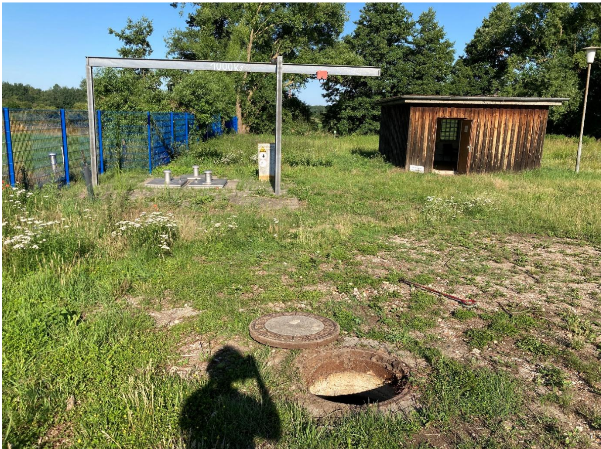
Kran-Trägerkonstruktion am Pumpwerk und Schachtabdeckung Freigefällekanal
