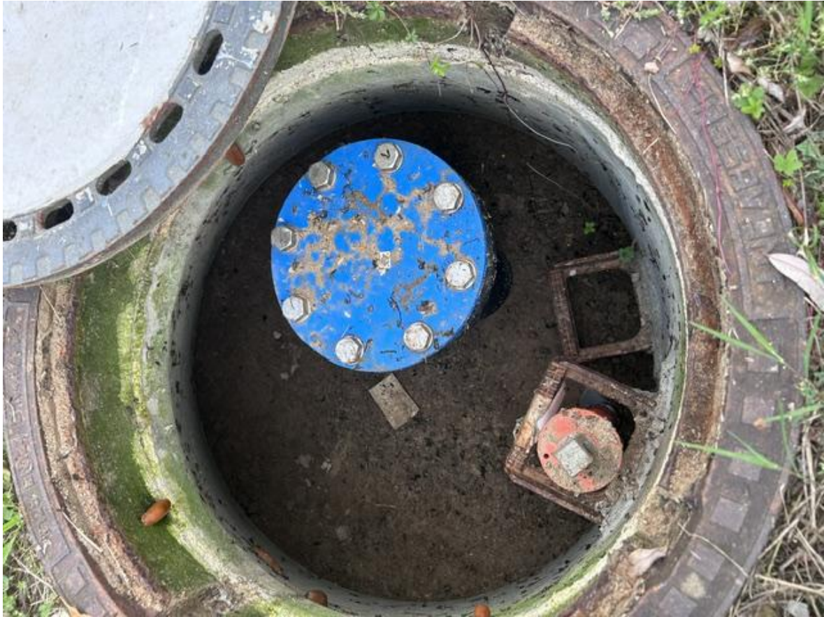
Anschluss an Druckrohleitung zum Pumpwerk Beienrode
