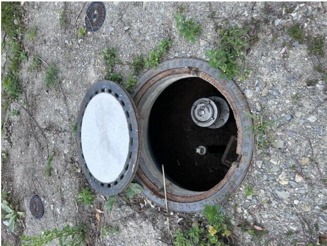
Anschluss Druckrohrleitung vom Gewerbegebiet an der A2
