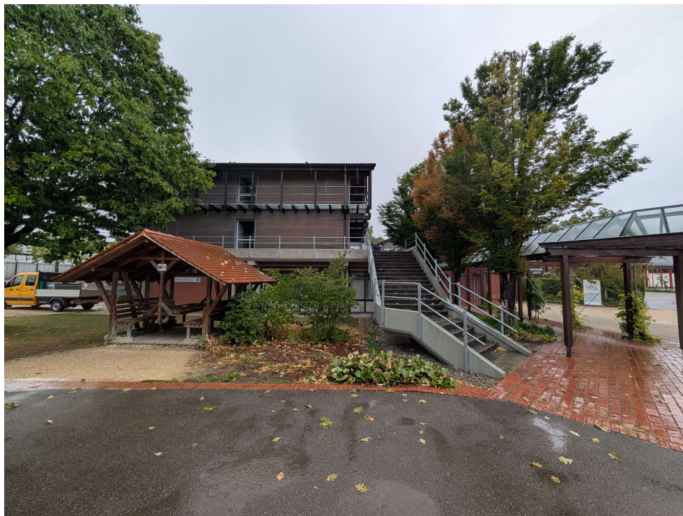
Abb 3: Internat, Blick von Südwest
