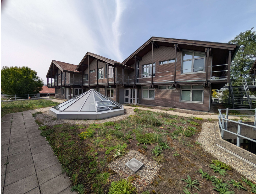
Abb. 5: Flachdach/Dachterrasse des Internats (1.OG), Blickrichtung Westen
