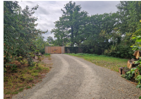
Hauptbaustellenzufahrt mit Bautor
