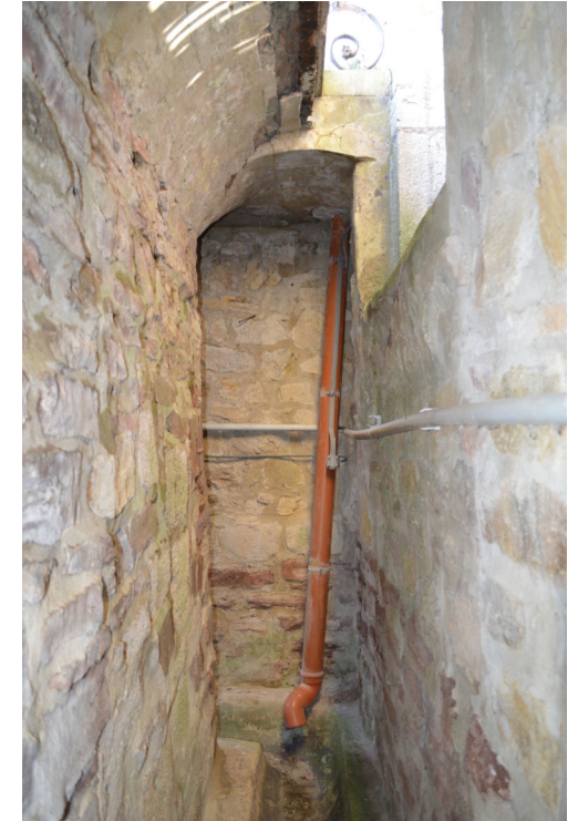
Entwässerungsgang mit Sandsteinrinne und Stahlträger Lichtschachteinfassung
