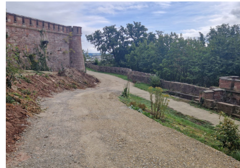
Baustraße südwestlich mit Blick auf Terrasse Süd
