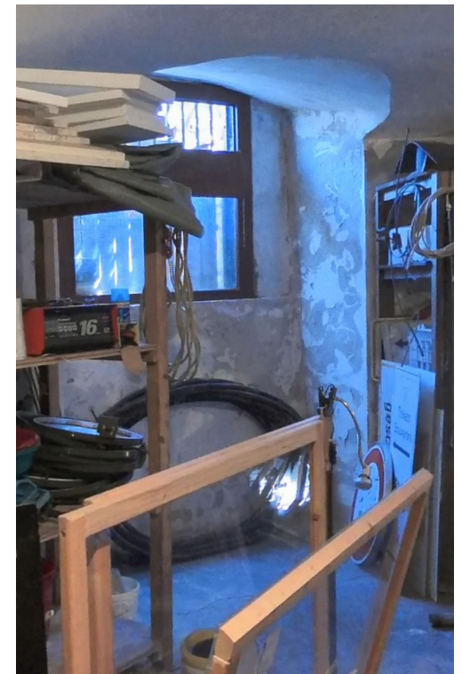
F_C-K.33/1, zukünftiger Zugang zum vorgelagerten Kellerraum
