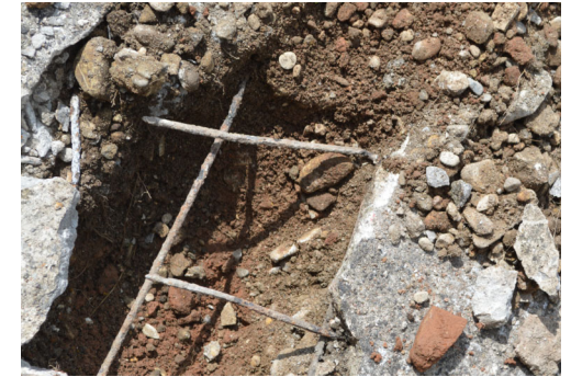
Erkundungsöffnung Betonschicht
