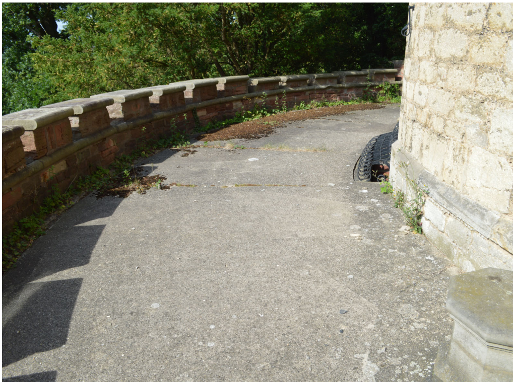
Kappendecke mit Betonschicht über dem vorgelagerten Kellerraum
