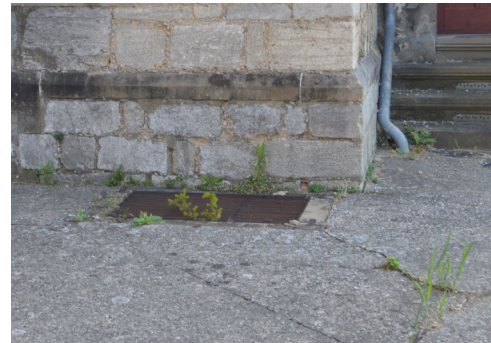
Horizontale Lichtschachtvergitterung und -einfassung am Rittersaal
