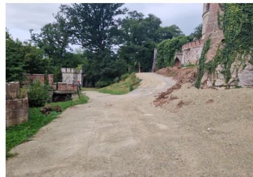
Baustraße südlich, Blick nach Westen
