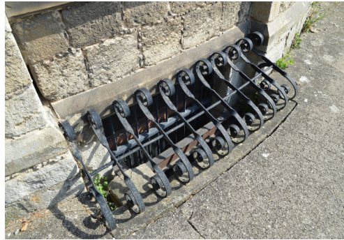
Ornamentale gebogene Lichtschachtvergitterung und -einfassung
