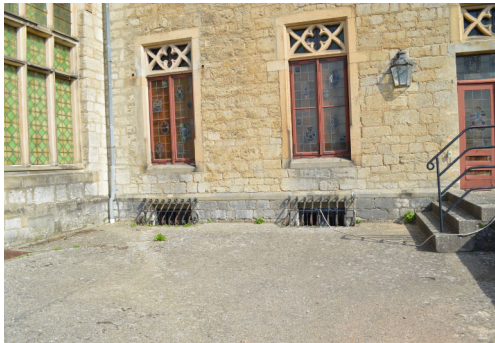
Ornamentale gerade Lichtschachtvergitterung am Südostflügel Südseite oberhalb des Entwässerungsgangs
