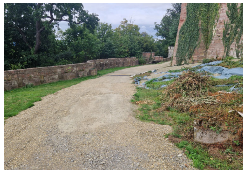
Baustraße südlich, Blick nach Westen
