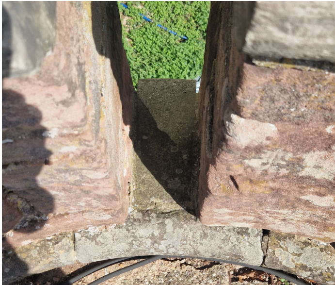
Schrägensicht Zinnenzwischenraumplatte aus Sandstein
