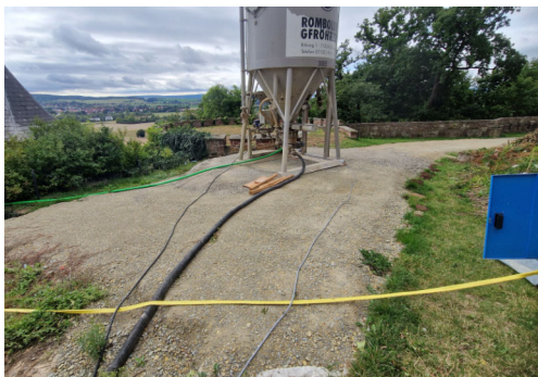
Baustraße südöstlich mit Blick auf Zisterne
