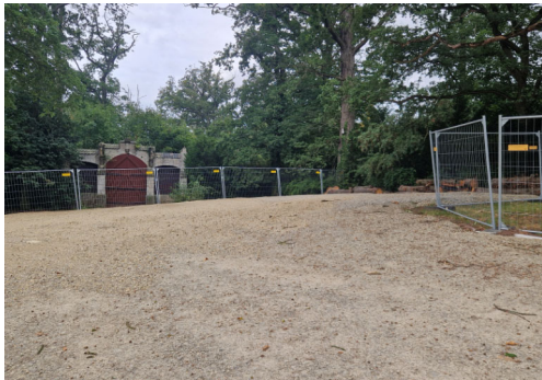
Baustelleneinrichtungsfläche Westflügel mit Blick auf Nürnbergertor
