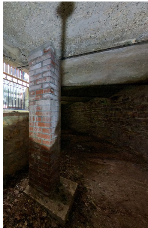
Ziegelpfeiler und Kappendecke im vorgelagerten Kellerraum
