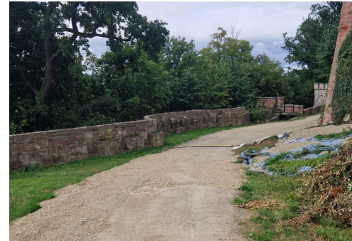
Baustraße südlich unterhalb Terrasse Süd
