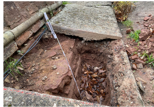
Erkundungsöffnung Betonschicht und Leitung aus mineralischen Baustoffen
