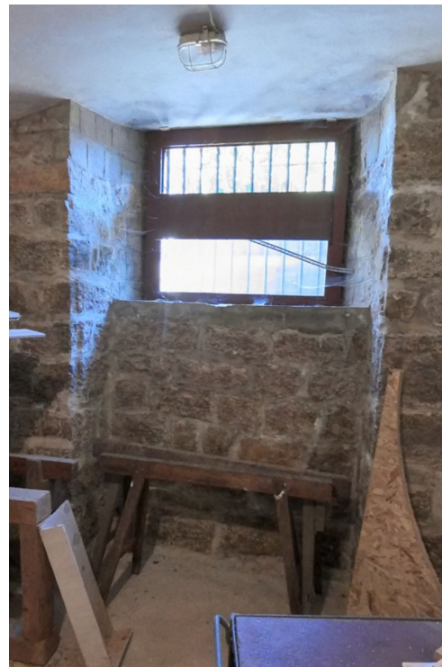
F_C-K.30, zukünftiger Zugang zum Entwässerungsgang
