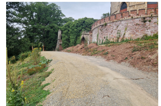
Baustraße mit Blick auf Bibliotheksturm
