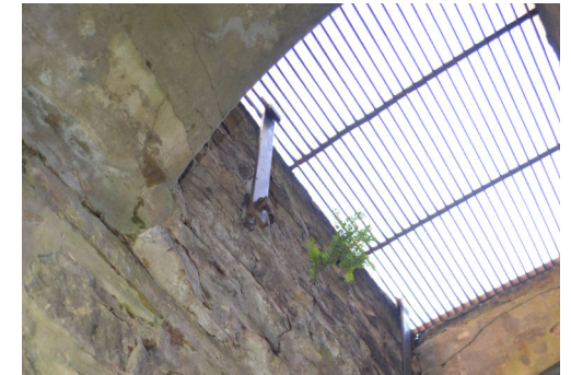
Horizontale Lichtschachtvergitterung und -einfassung am Rittersaal vom Entwässerungsgang aus betrachtet
