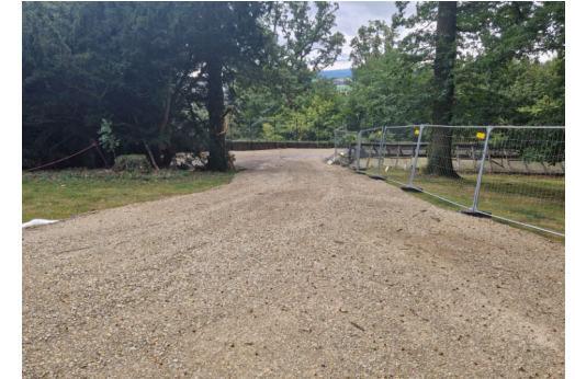
Baustraße, Blick von Baustelleneinrichtungsfläche Westflügel
