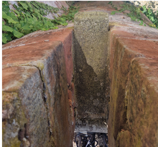
Aufsicht Zinnenzwischenraumplatte aus Sandstein
