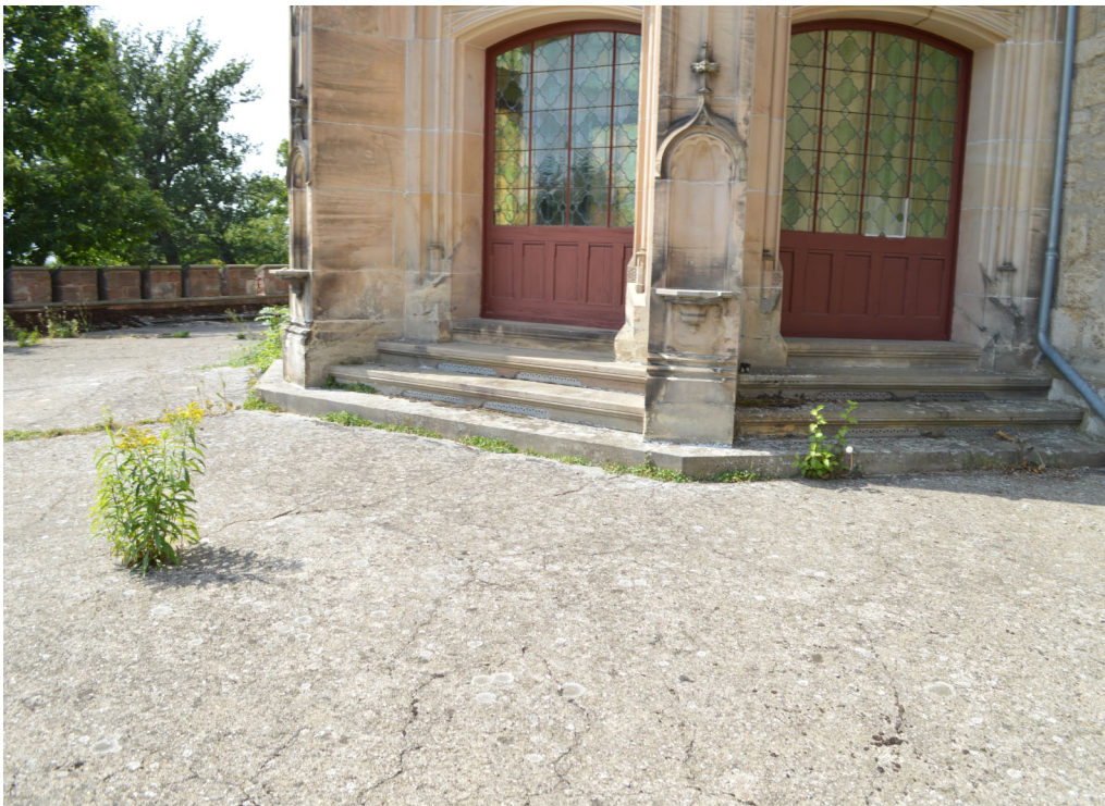
Beton-schicht über dem Entwässerungsgang, die der Polygonform des Gebäudes folgt
