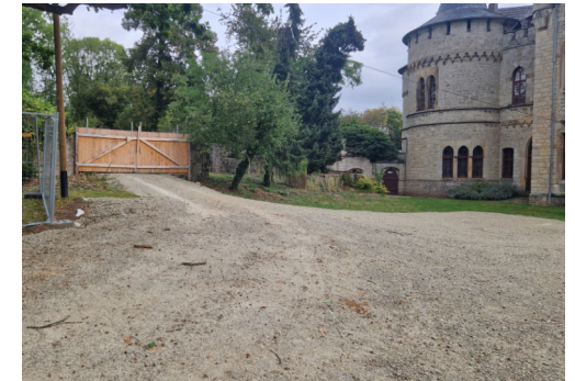
Baustelleneinrichtungsfläche Westflügel mit Blick auf Bautor
