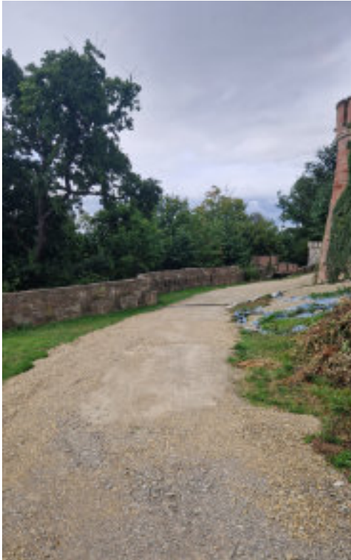
Baustraße südlich unterhalb Terrasse Süd
