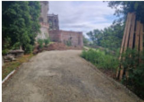
Baustraße südwestlich mit Blick auf Terrasse Süd
