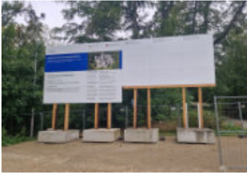
Bauschild auf Baustelleneinrichtungsfläche Besucherparkplatz
