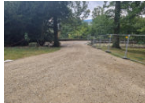
Baustraße, Blick von Baustelleneinrichtungsfläche Westflügel
