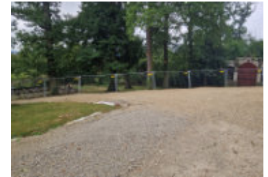
Baustelleneinrichtungsfläche Westflügel mit Blick auf Nürnbertor
