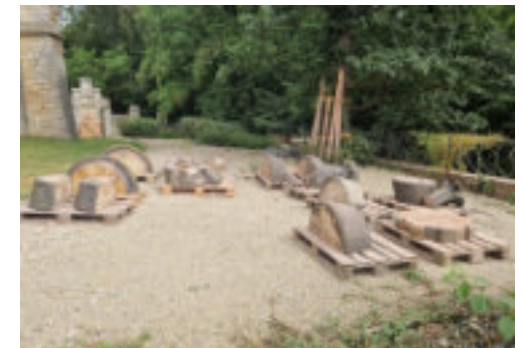
Baustelleneinrichtungsfläche Ostflügel (aktuell noch belegt)
