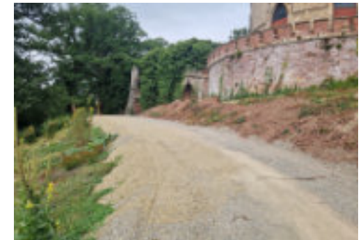
Baustraße mit Blick auf Bibliotheksturm
