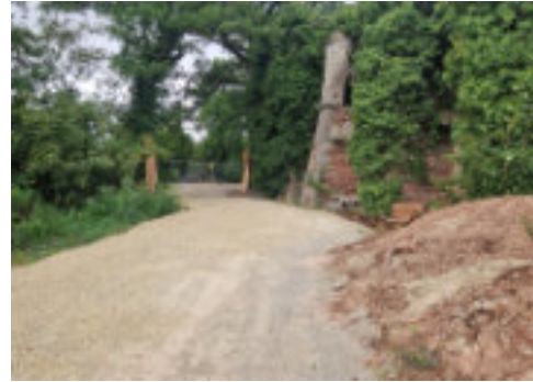
Baustraße südwestlich mit Blick auf Löschbecken
