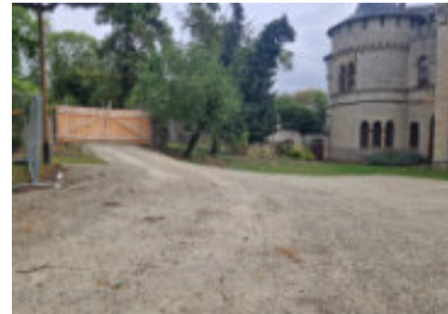
Baustelleneinrichtungsfläche Westflügel mit Blick auf Bautor
