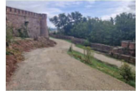
Baustraße südwestlich mit Blick auf Terrasse Süd
