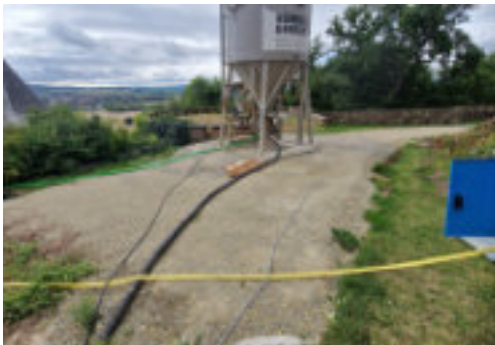
Baustraße südöstlich mit Blick auf Zisterne
