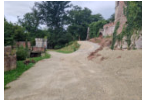
Baustraße südlich, Blick nach Westen
