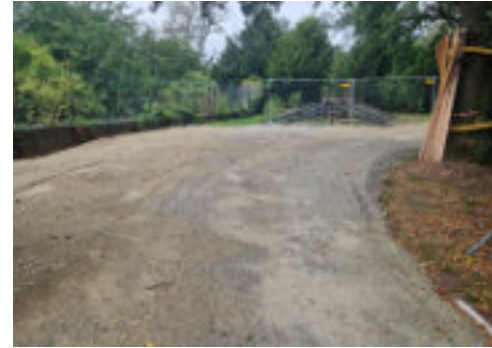
Baustraße südwestlich, Löschbecken
