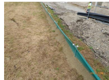
Amphibienschutzzaun zur Vermeidung der Einwanderung von Zauneidechsen in Baufelder o.ä.
