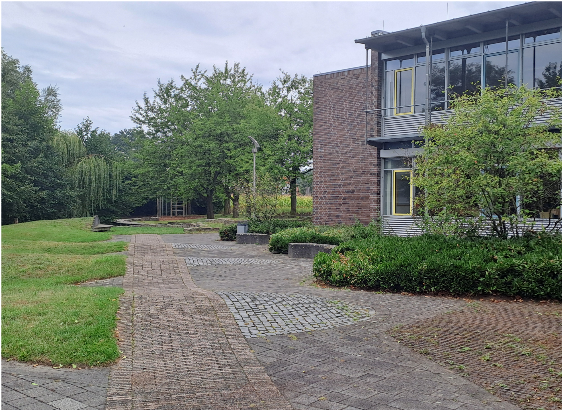
Blick vom Schulhof auf Baufeld
