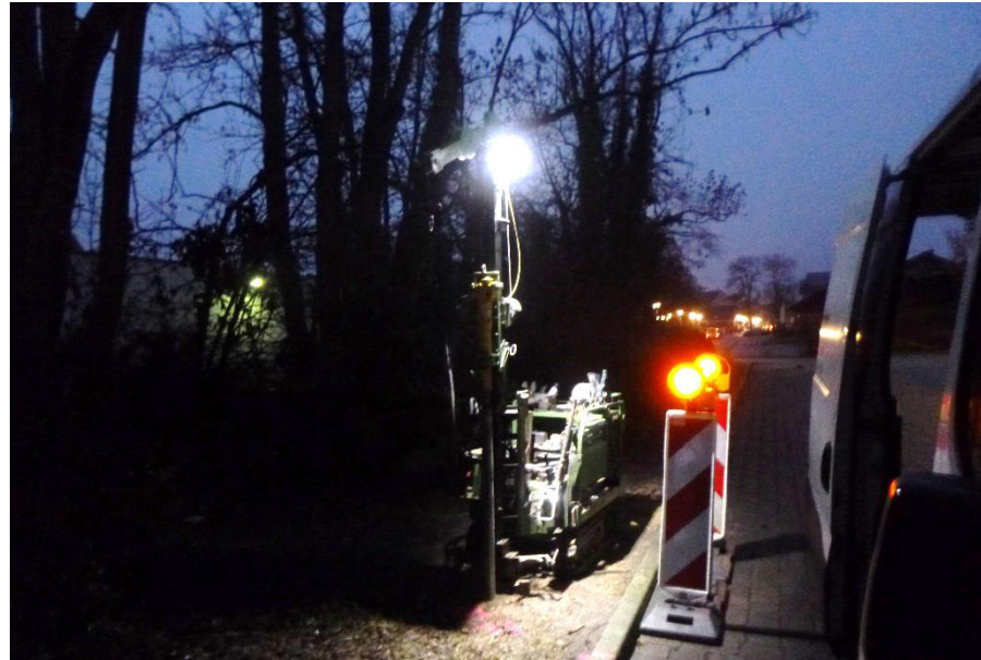
Abb. 15: Untersuchungspunkt DPM 7 | KRB 7 - Blickrichtung Westsüdwest
