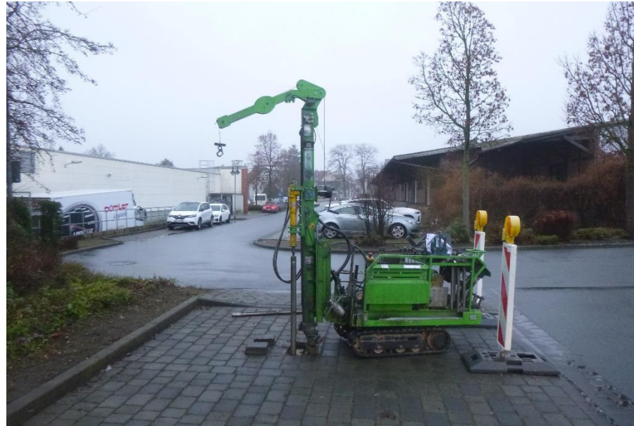
Abb. 13: Untersuchungspunkt DPM 6 | KRB 6 - Blickrichtung Westsüdwest
