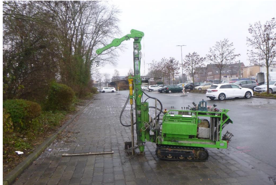
Abb. 17: Untersuchungspunkt DPM 8 | KRB 8 - Blickrichtung West
