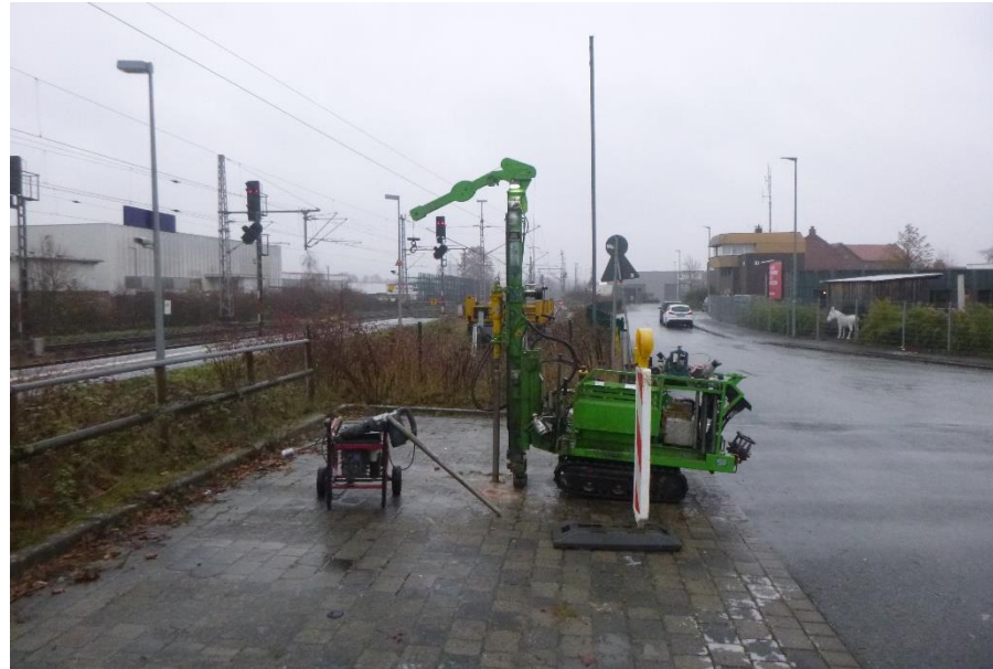
Abb. 6: Untersuchungspunkt DPM 3 | KRB 3 - Blickrichtung Ostnordost
