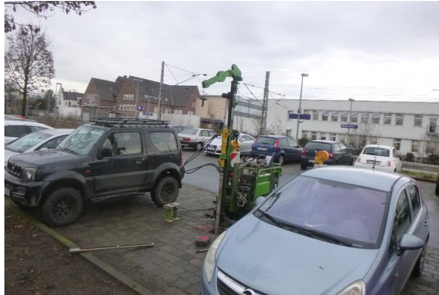
Abb. 8: Untersuchungspunkt DPM 4 | KRB 4 - Blickrichtung Westnordwest
