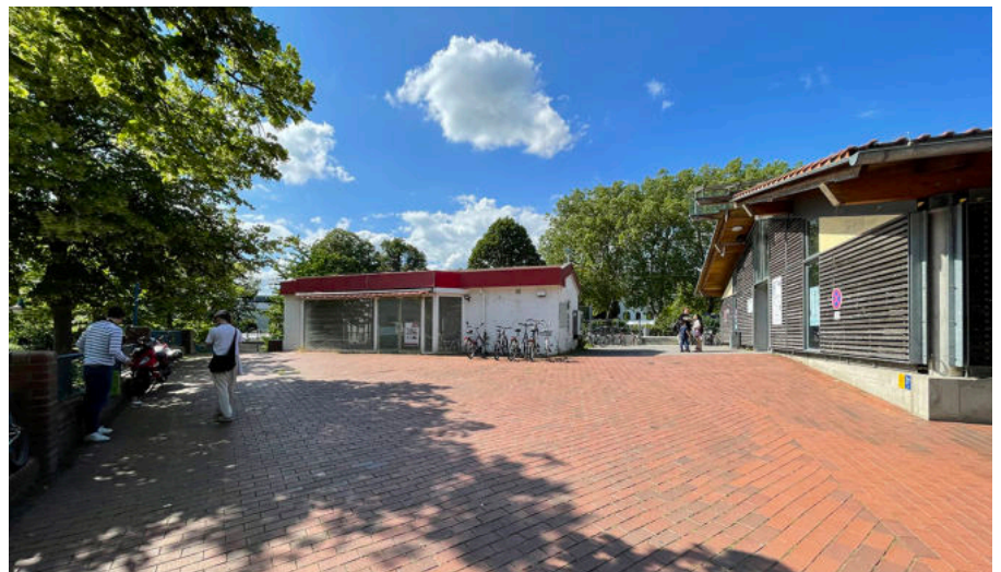
Abb. Leerstehender Pavillon (links), Radstation (rechts) (Quelle: DHP 2022)
