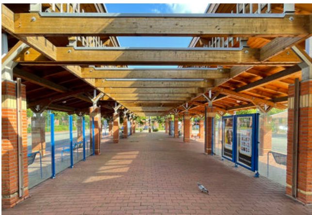
Abb. Zentraler Wartebereich mit Überdachung (Quelle: DHP 2022)
