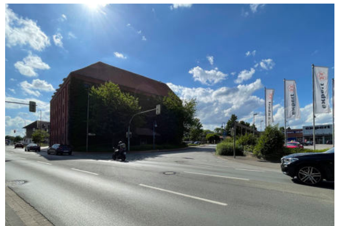
Abb. Zu-/Abfahrtsituation Lichtsignalanlage (LSA) Wasserbreite (Quelle: DHP 2022)
