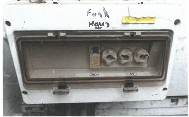
Bild 2: Kleinverteiler mit den Abgängen -F40 und -F41 im Außenschaltschrank (Teil 2)
