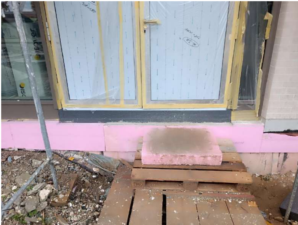
Tür an TH 01 mit 9,3m Fassadenrinne über Perimeterdämmung.
