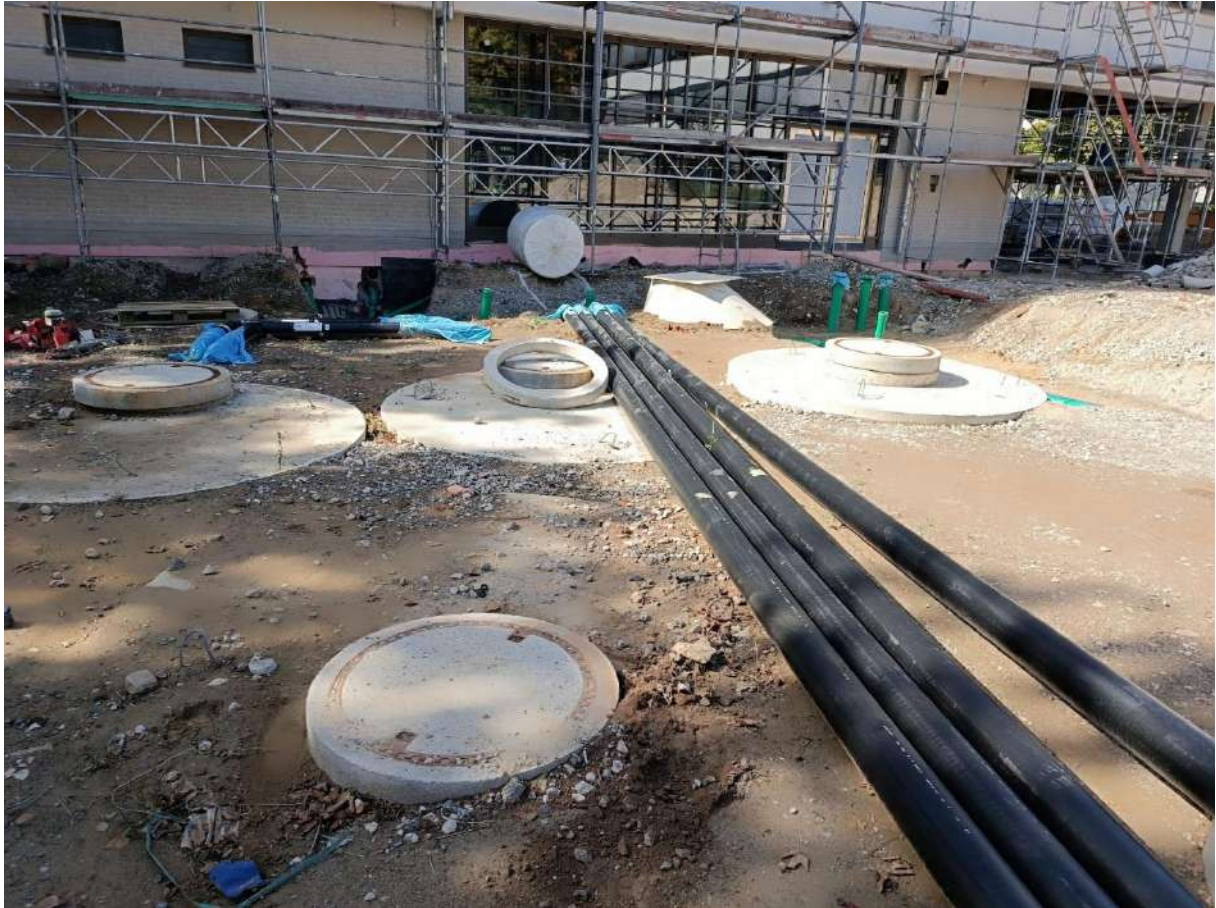
Baufeld im Bereich der großen Regenwasserzisternen
