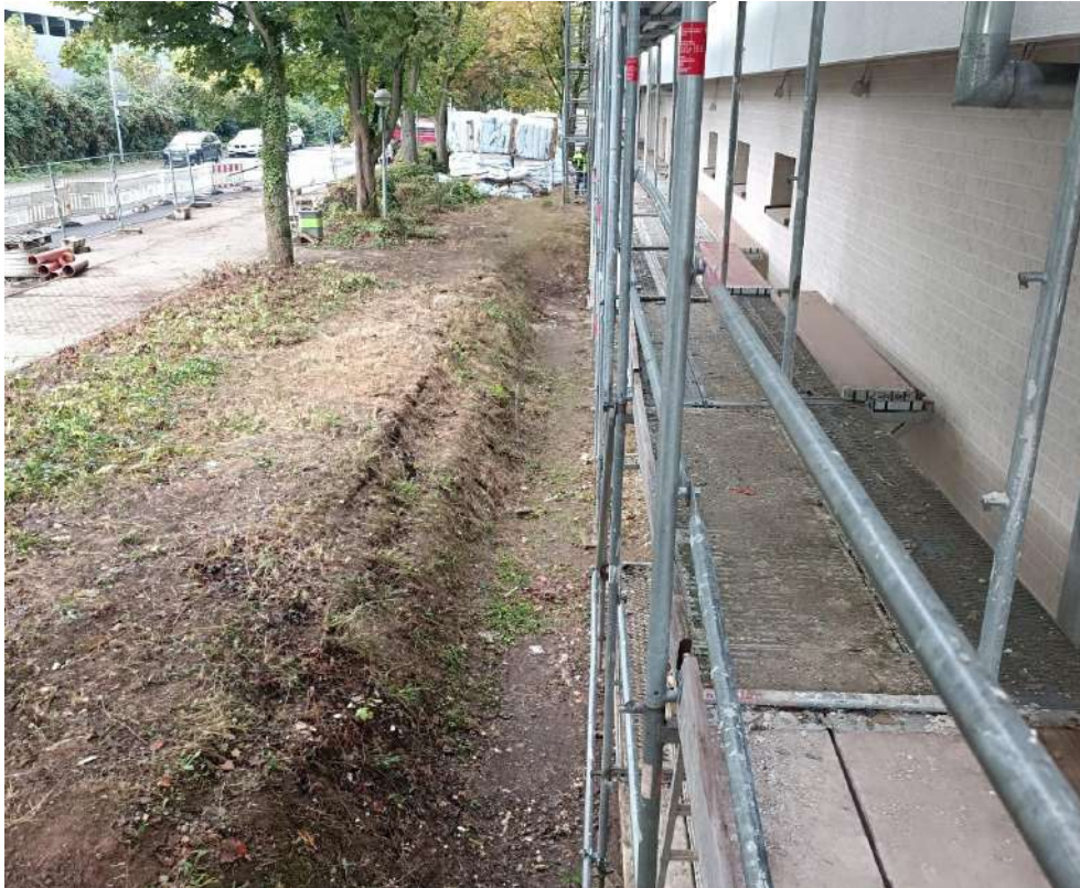
Bereich Neubau Richtung Schulstraße
