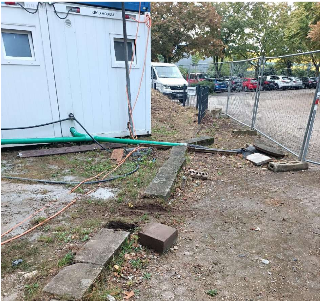
Baubereich Richtung Sporthalle: hier die zu entsorgenden Betonblockstufen. Der im Hintergrund sichtbare Toilettencontainer wird Anfang März 2027 abgeholt.
