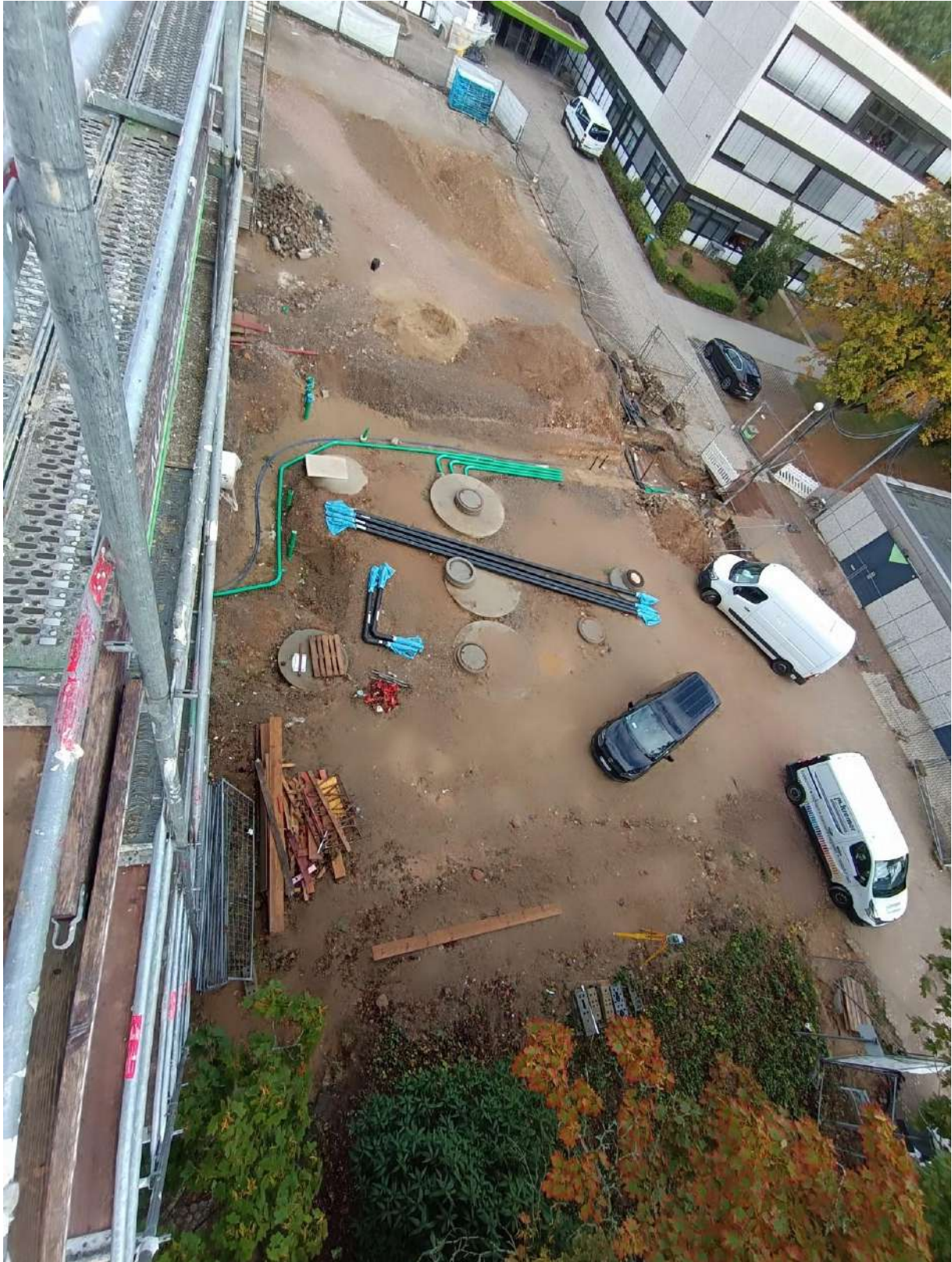
Übersichtsfoto: Baufeld Richtung Garagen Hausmeister und oben Haupteingang des
