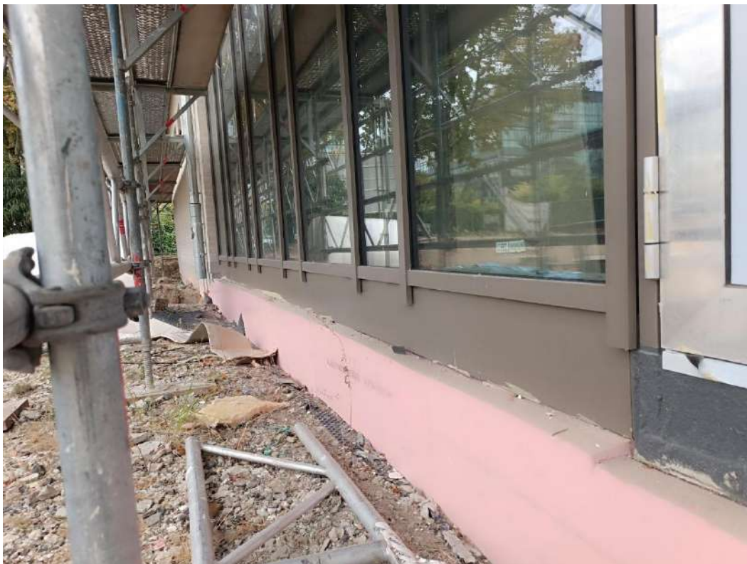
Pfosten-Riegelfassade bei TH 01. 9,30m. Fassadenrinne über Perimeterdämmung.
