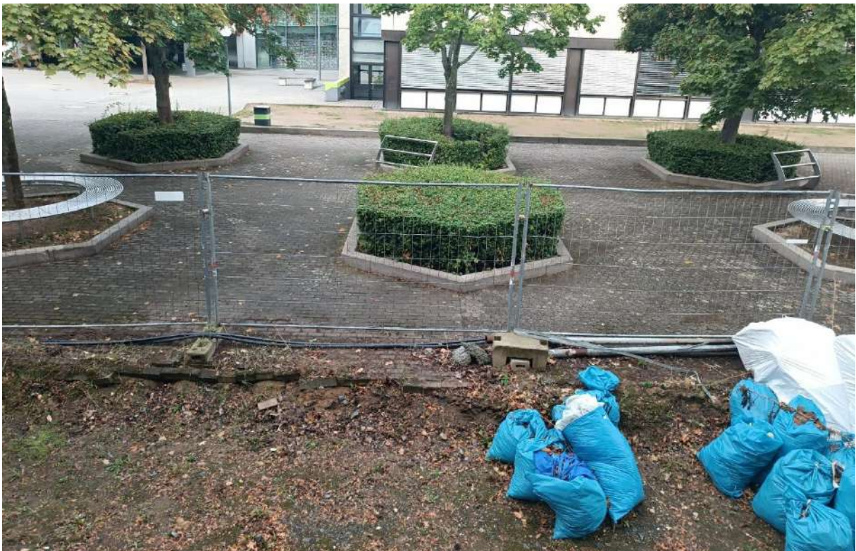
Bestandspausenhof mit Doppel-Sechseckpflaster Richtung Alt-Schulgebäude.
