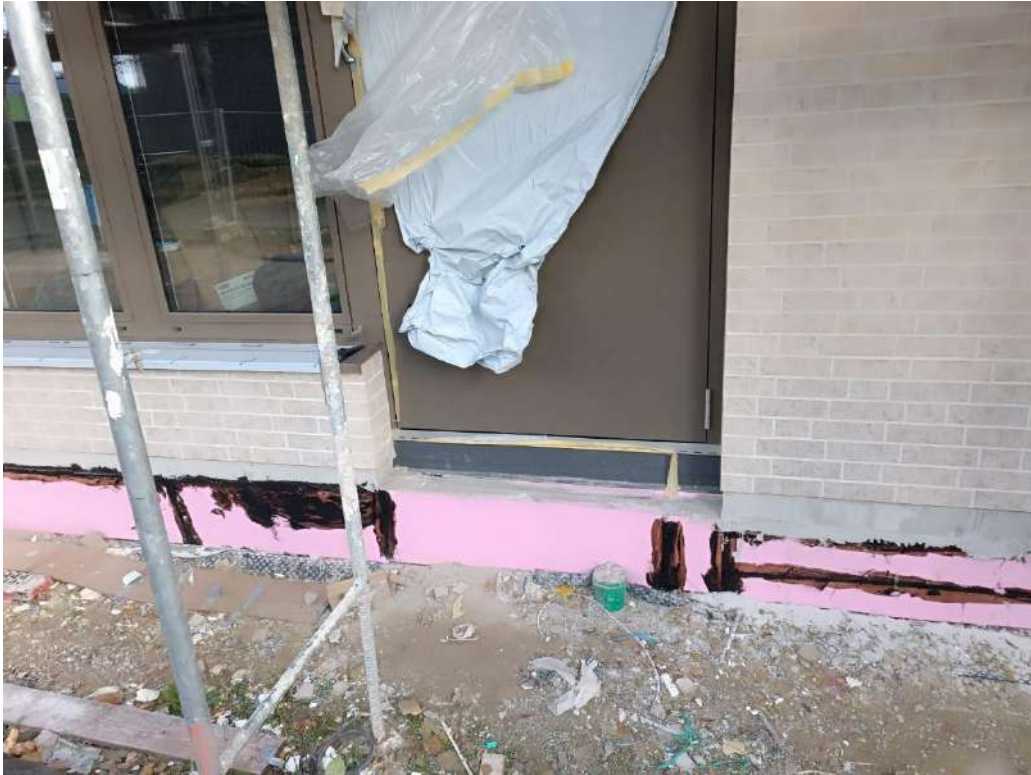
Fassade Richtung Sporthalle, Einbaubereich für Fassadenrinne von ca. 1,45m Länge
