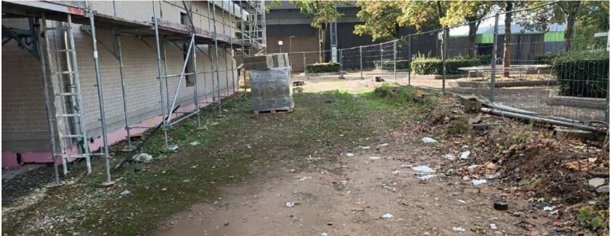
Baufeld Richtung Alt-Schulgebäude.
