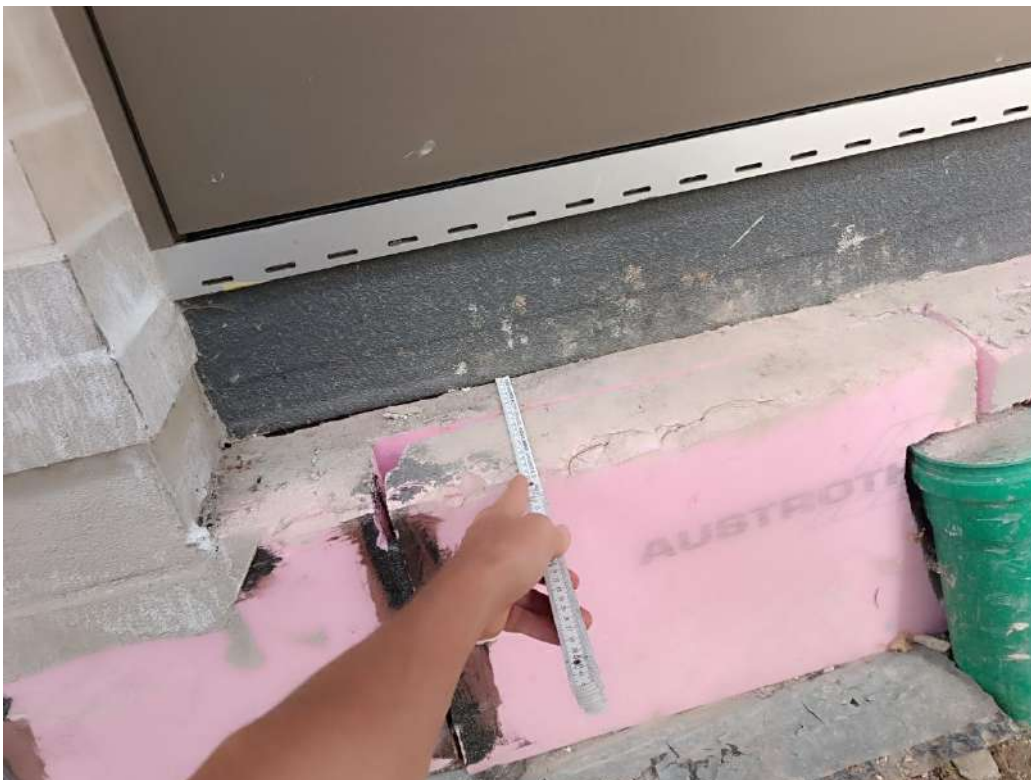
Fassade Richtung Sporthalle, Detailbild für Einbau einer Pass-Fassadenrinne von ca. 1,45m Länge über auskragender Perimeterdämmung.
