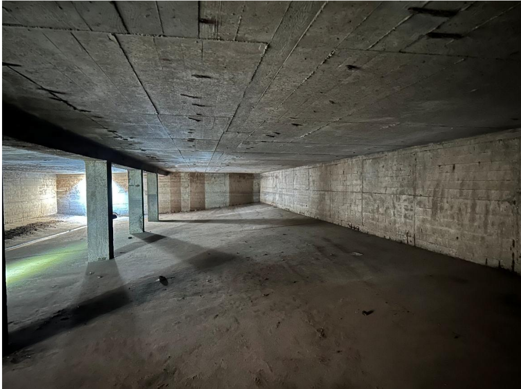
Abb.: 08: Decke, Unterzug, Stützen und Wände. Blick in Fließrichtung.
