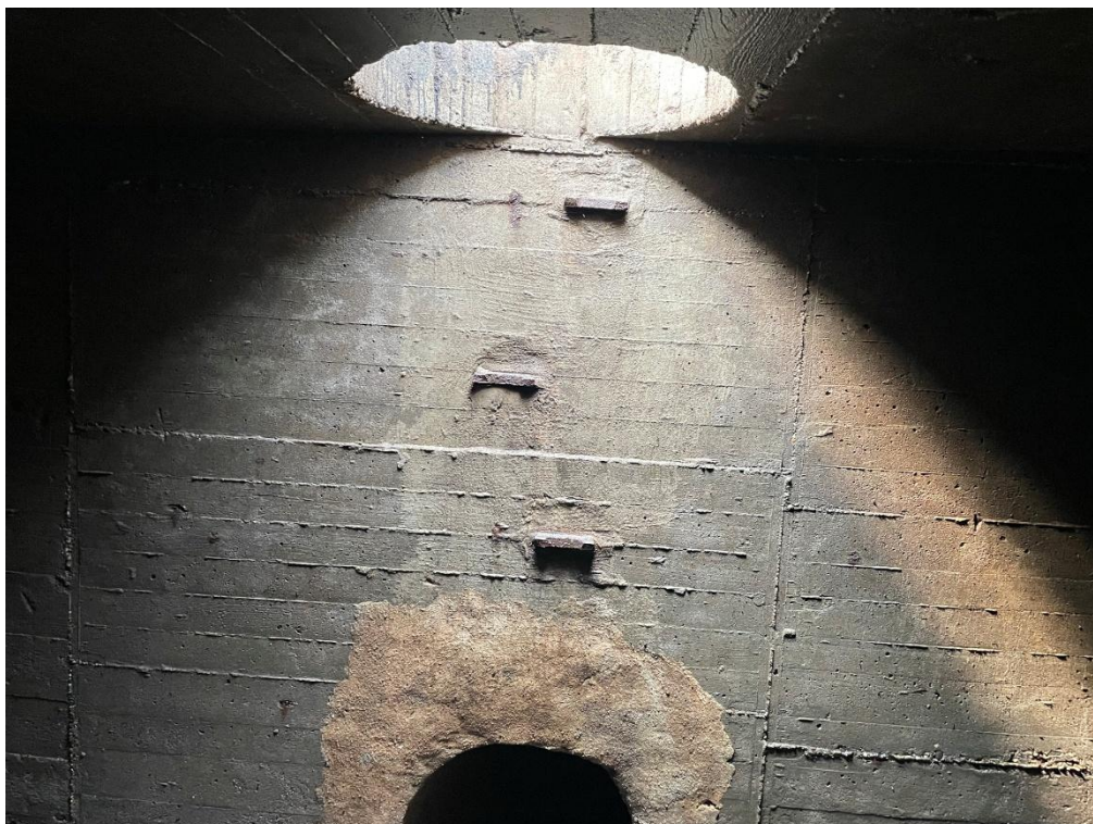
Abb.: 05: Einstiegsöffnung DN 600 auslaufseitig
