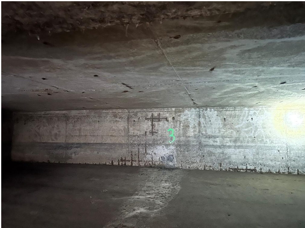
Abb.: 09: Großflächige Schadstellen im Bereich der Wandflächen.
