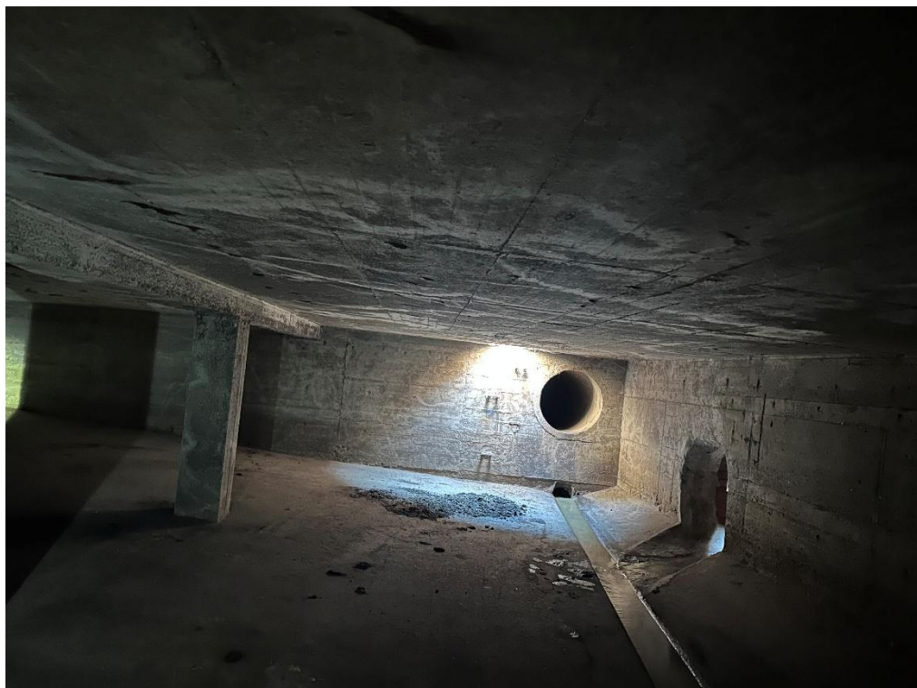
Abb.: 11: Zulauf DN 1000 mit Untersturz DN 250 und seitlicher Zulauf DN 1000, Blick entgegen der Fließrichtung.
