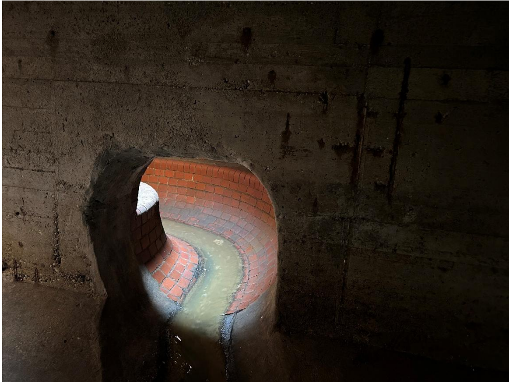
Abb.: 10: Zulauf DN 1000. Schachtbauwerk unmittelbar vor dem RRB mit Klinker-Gerinne.
