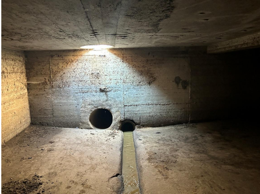
Abb.: 12: Auslauf DN 250 und Auslauf DN 500. Blick in Fließrichtung.
