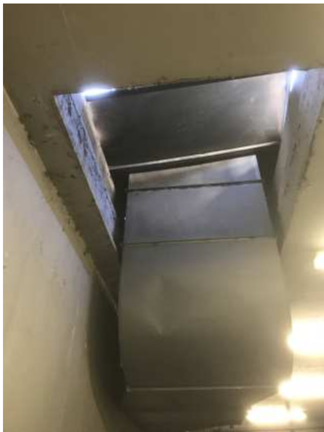
Innenansicht - bestehende Montageöffnung in KG-Decke mit 'integriertem' Zuluftkanal. Abmessungen - siehe beiliegende Planunterlagen
