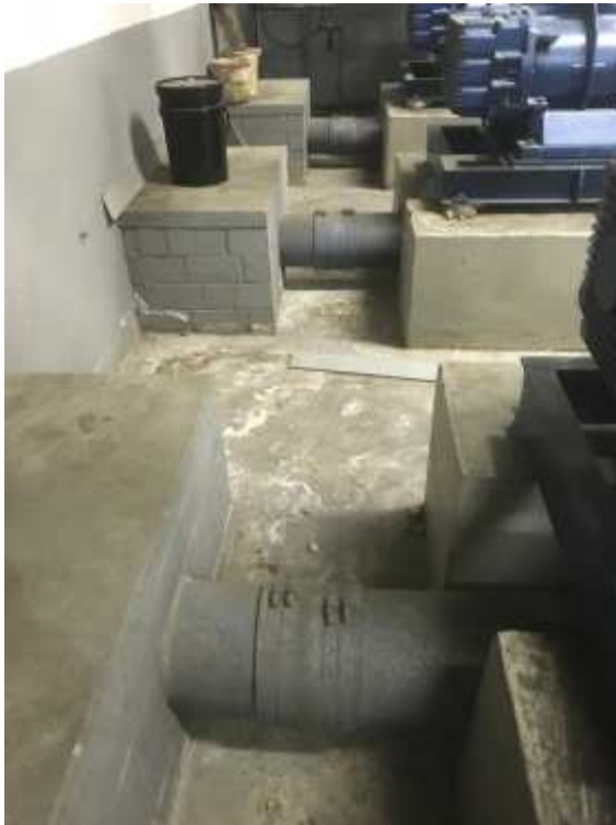
alte Saugleitungen aus Zuluftkanal mit Manschettendichtung - zu demontieren
