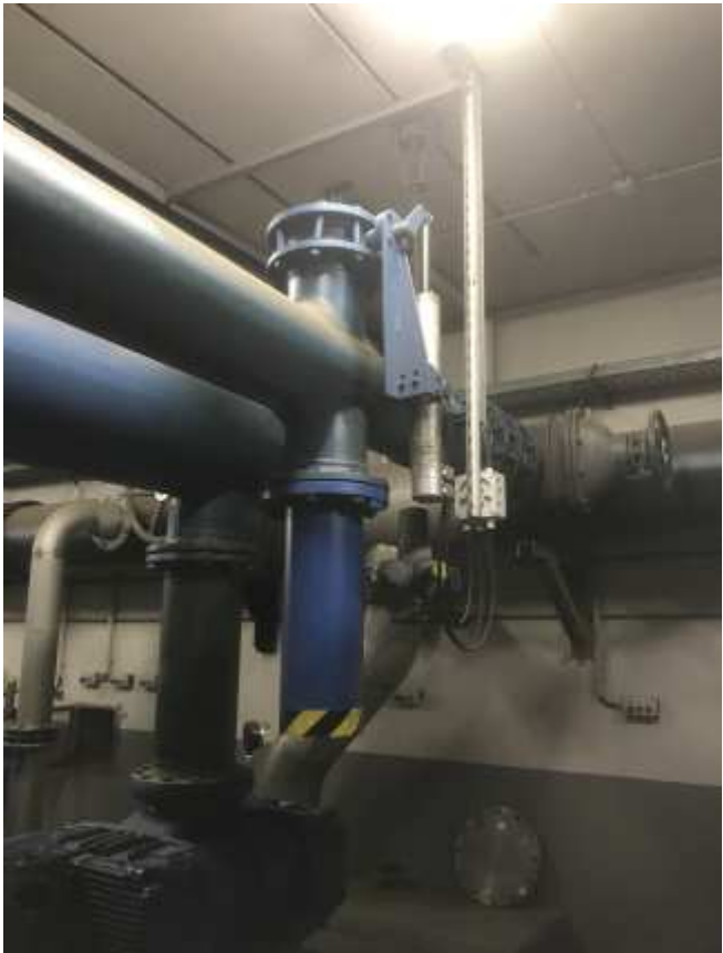
alte Anfahrentlastungen - zu demontieren
