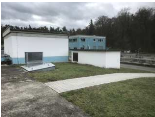
Bestehende Montageöffnung in KG-Decke - links mit Zuluftkasten und Abdeckblechen in St.fverzk - Außenansicht
