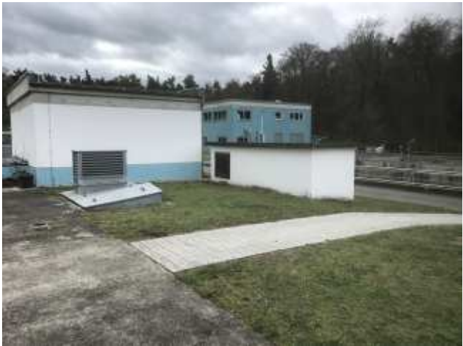
Bestehende Montageöffnung in KG-Decke - links mit Zuluftkasten und Abdeckblechen in St.fverzk - Außenansicht 1,000 St .....
