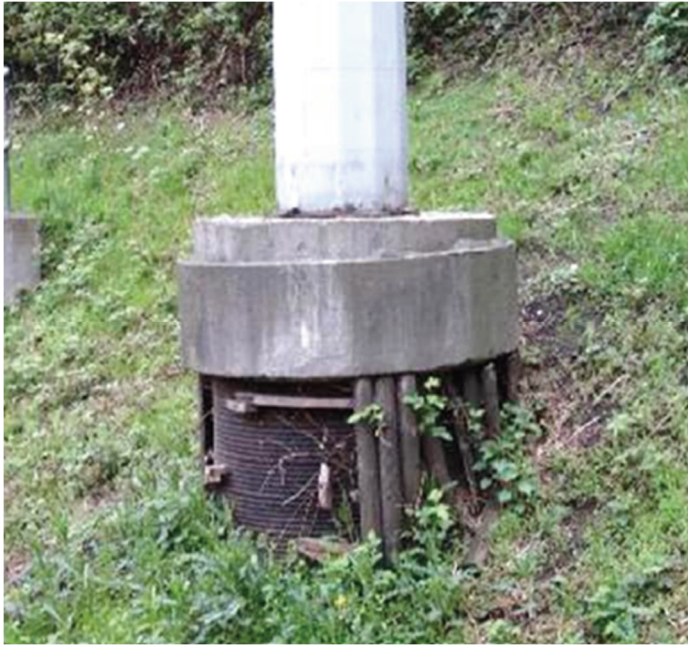
Abb. 15c: Fundament LHM N1; Quelle: WTM 19.12.24
