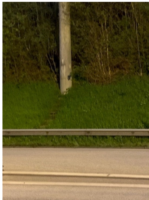
Abb. 17a: Standort LHM N2; Quelle: Foto HHVA
