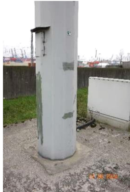
Abb. 24c: Fundament LHM S4a; Quelle: WTM 19.12.24
