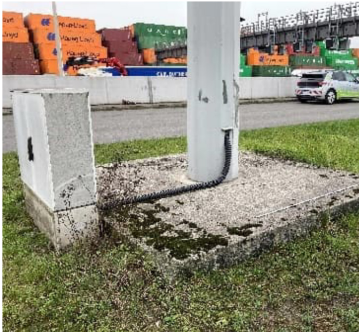
Abb. 24b: Fundament LHM S4a; Quelle: WTM 19.12.24
