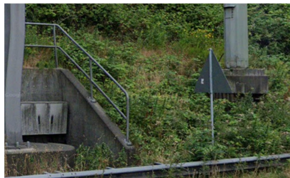
Abb. 15a: Schaltschrank LHM N1; Quelle: Foto HHVA
