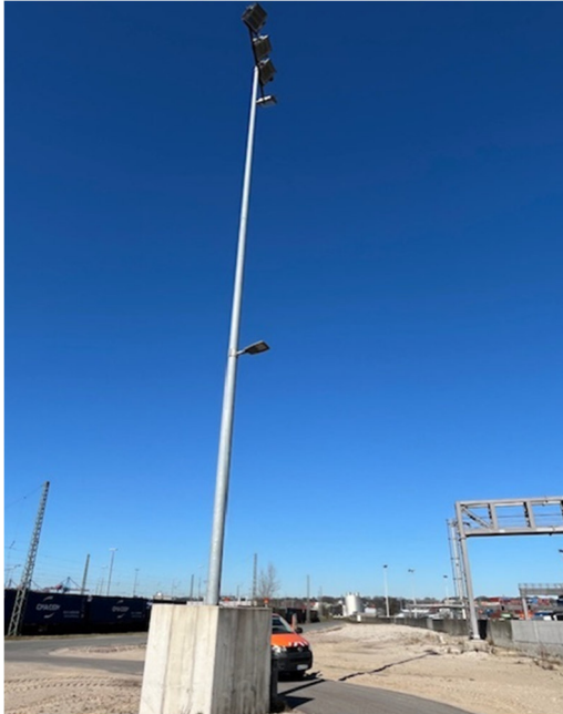
Abb. 26: Standort prov. LHM 6; Quelle: Foto HHVA
