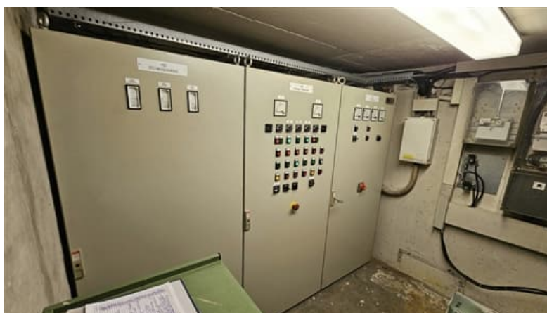
Erneuerung der Niederspannungsschaltanlage und der TGA im Hebewerk 11 (Südost) sowie der Absperrschieber mit Elektrostellantrieb
