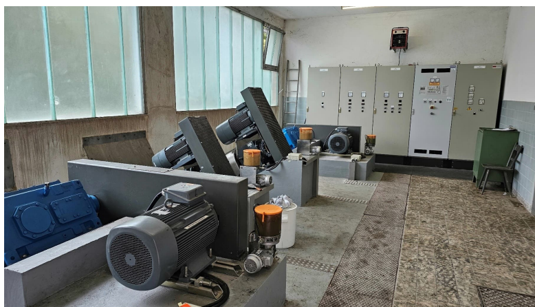
Erneuerung der Niederspannungsschaltanlage und der TGA im Hebewerk 3
