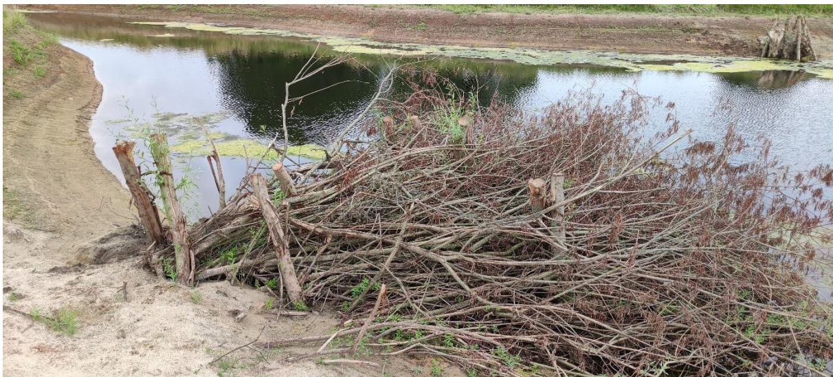
Abbildung 5: Astholz befestigt mit bereits ausschlagenden Weidenpfählen
