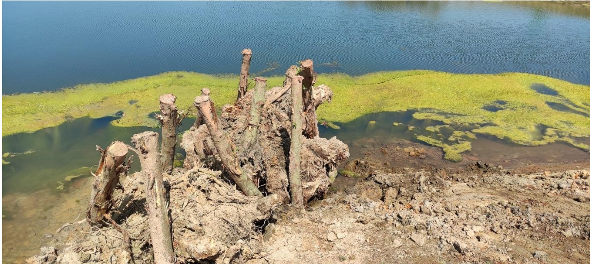
Abbildung 4: Wurzelballen befestigt mit Weidenpfählen
