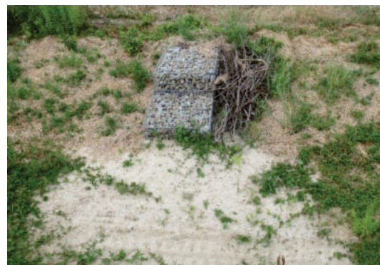
Steinkörbe mit Überdeckung (BILANUM 2019)
