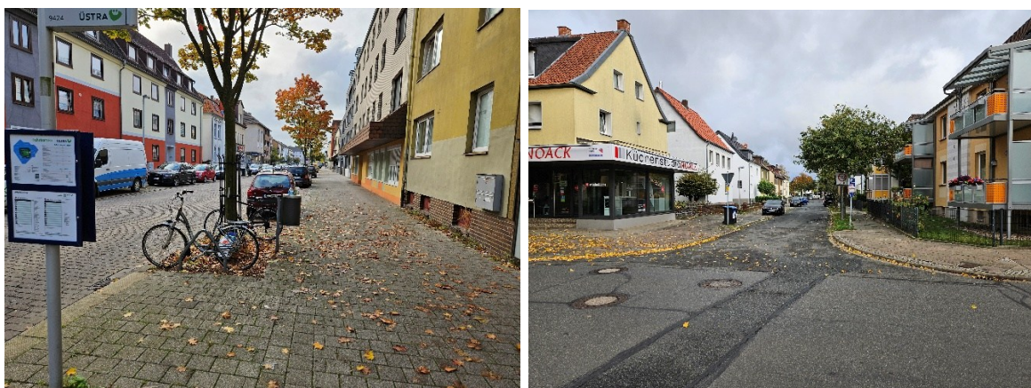
Abbildung 1-5: Impressionen des Versorgungsgebiet zur Oberflächenbeschaffenheit und der baulichen Struktur. Quelle: Eigene Fotos
