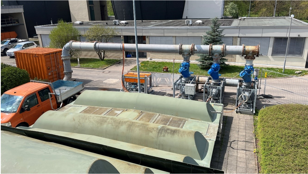
Abbildung 9: Mobile Pumpstation vor Hebeanlage II
