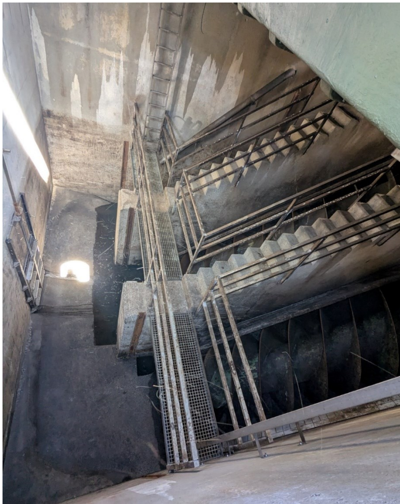
Abbildung 10: Hebeanlage II von innen (Gitterrostebene, Leiter, Geländer und Schneckenpumpen werden bauseits demontiert)
