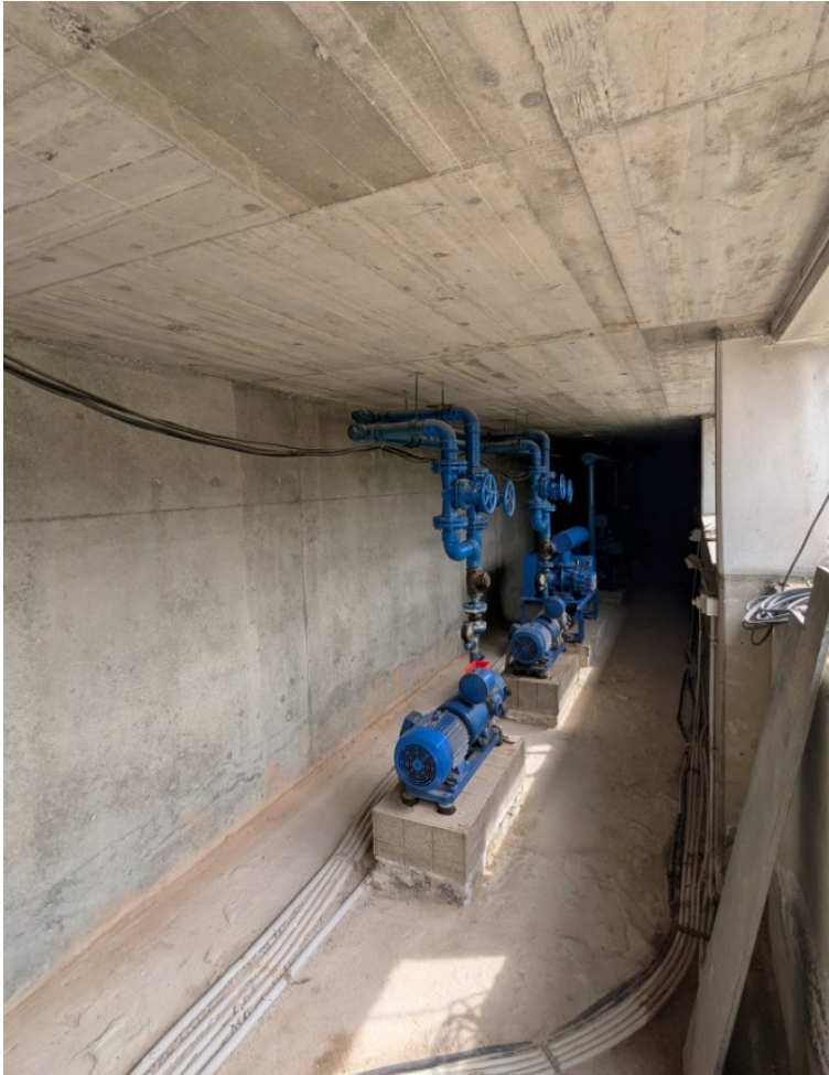
Abbildung 27: Gebläseraum mit Aggregaten, die im Betrieb sind und zu schützen sind
