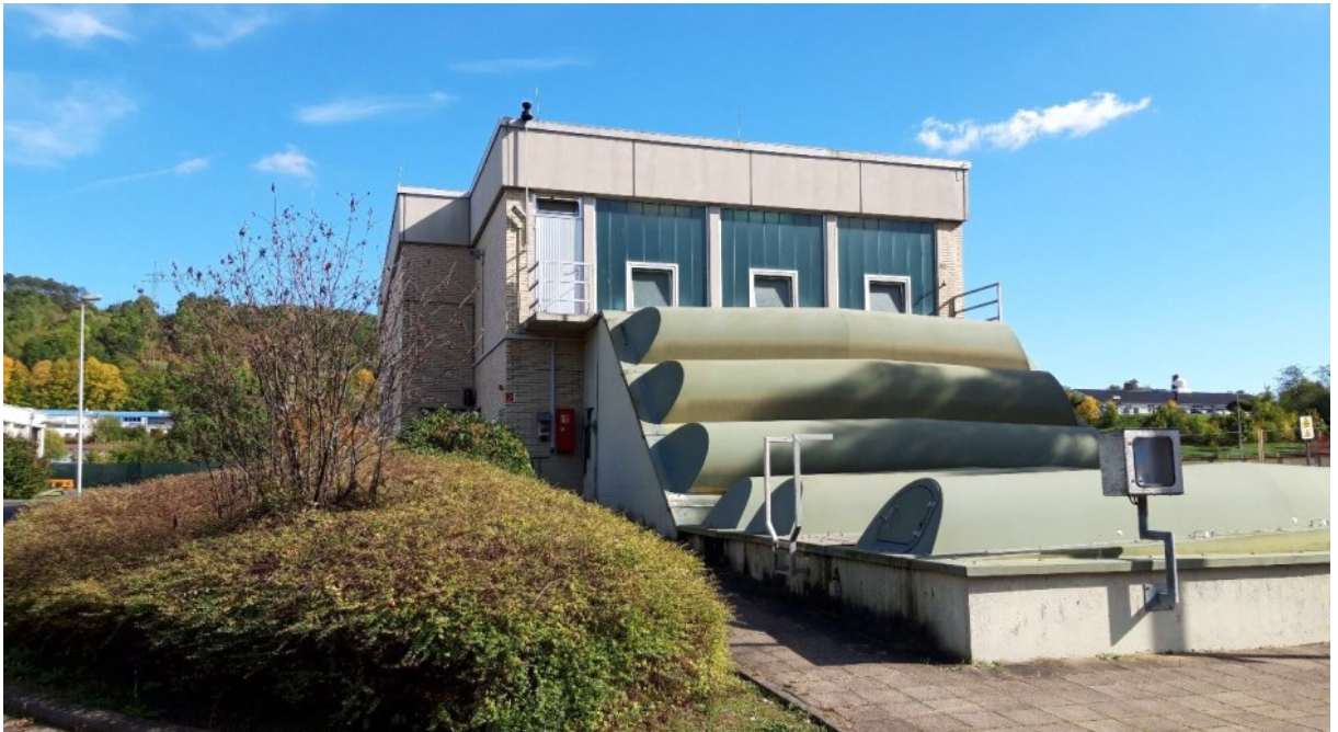
Abbildung 7: Hebeanlage, die GFK-Abdeckung wird für die Betonsanierungsarbeiten demontiert sein
