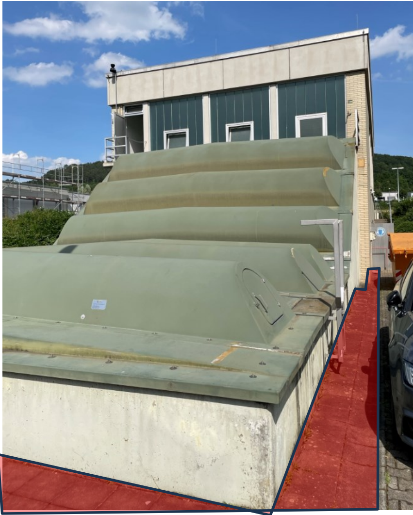
Abbildung 19: Bauseitiger Graben rund um Hebeanlage II
