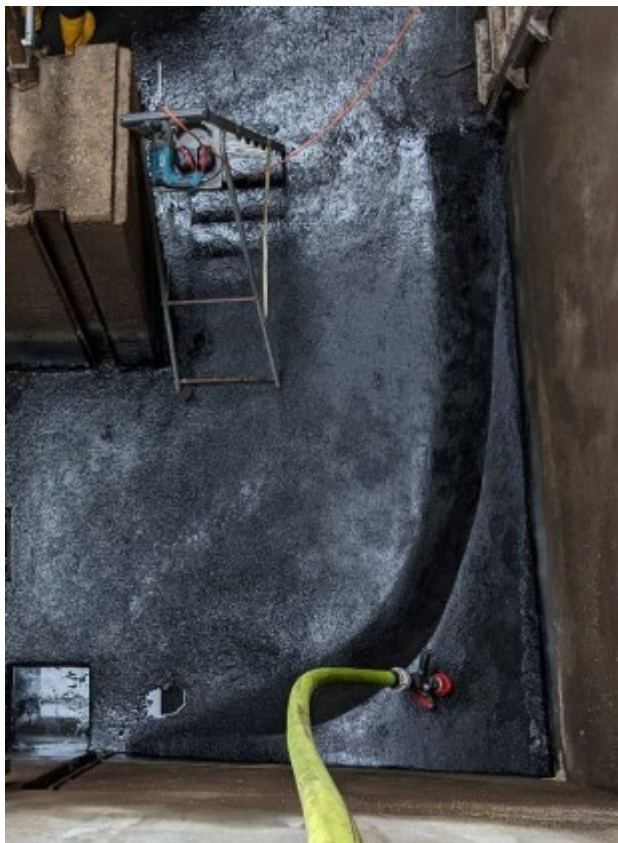
Abbildung 12: Profilierung Boden
