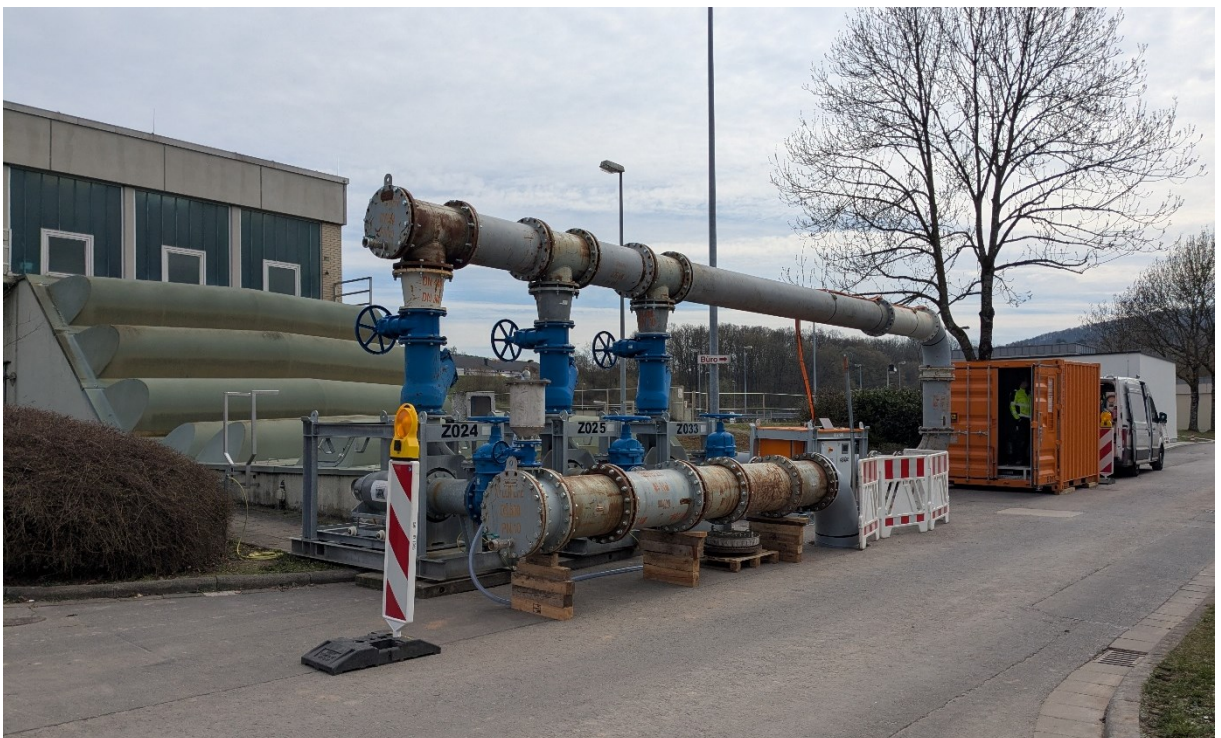
Abbildung 8: vor der Hebeanlage II ist eine mobile Pumpstation installiert.
