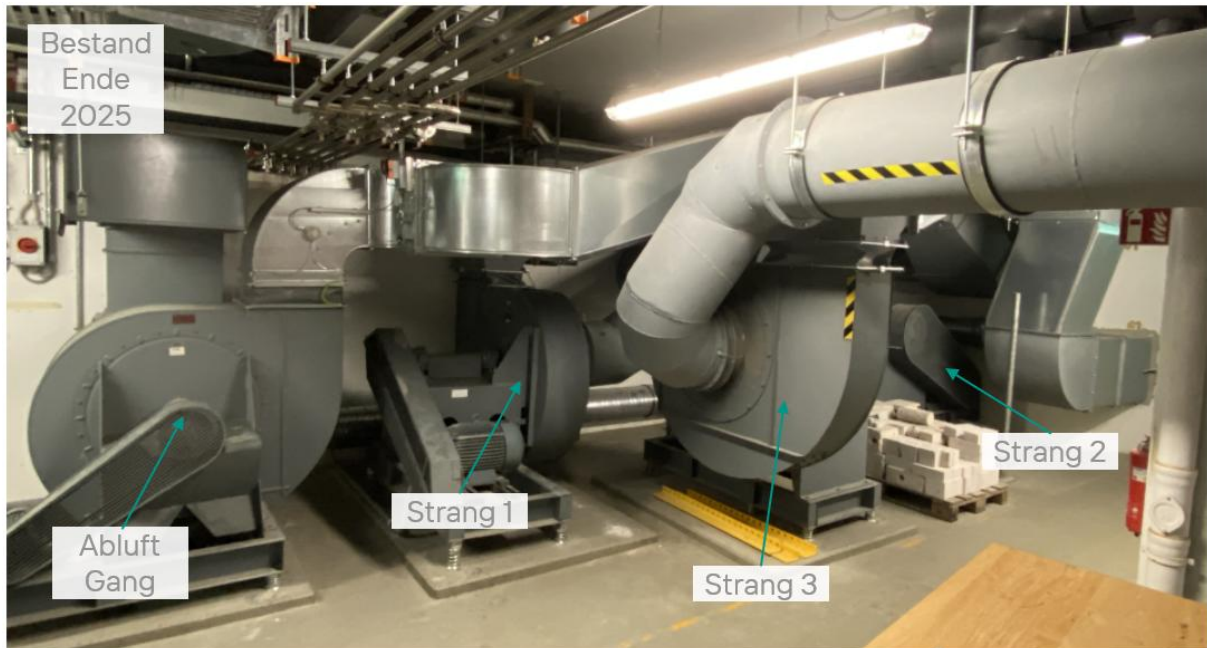
Abbildung 8 Bestand Ventilatoren/Kanäle vor Umbau
